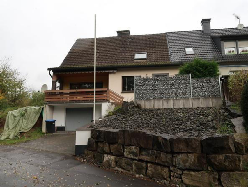
Ansicht vom Ahlenbergweg.
