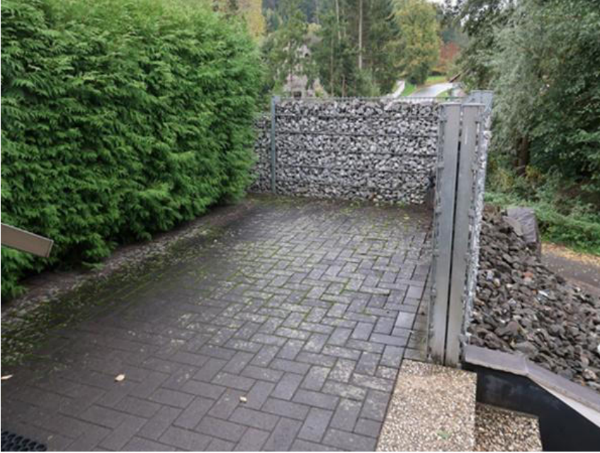
Podest mit Betonsteinpflasterung vor dem Hauseingang.
