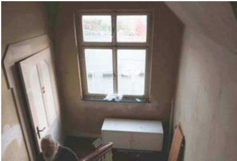
Treppenhaus – Podest zwischen EG und OG, links im Bild die Tür zum Abstellraum mit WC
