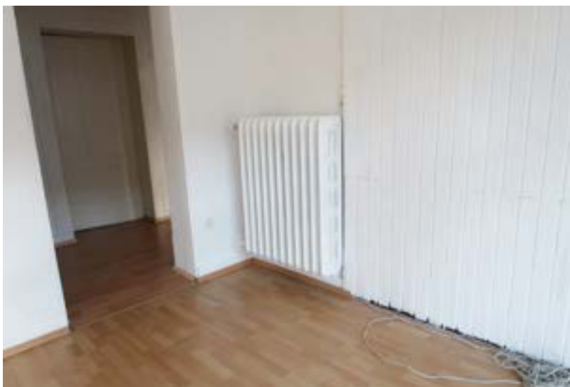
Provisorisch angebrachte Paneele zur Trennung der beiden Wohnräume
