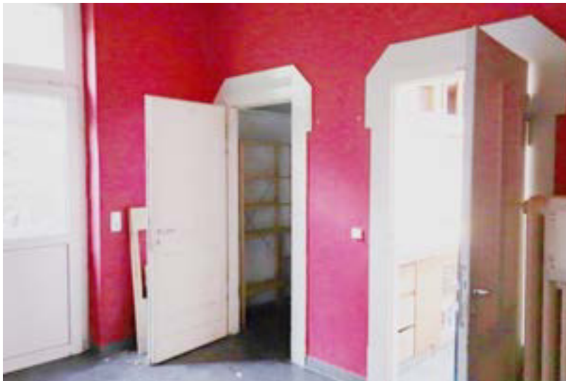
Küche – rechts im Bild die Zugänge zum Bad und dem Abstellraum
