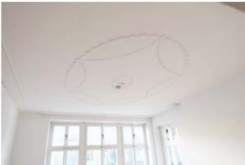
Stuckarbeiten an der Decke
