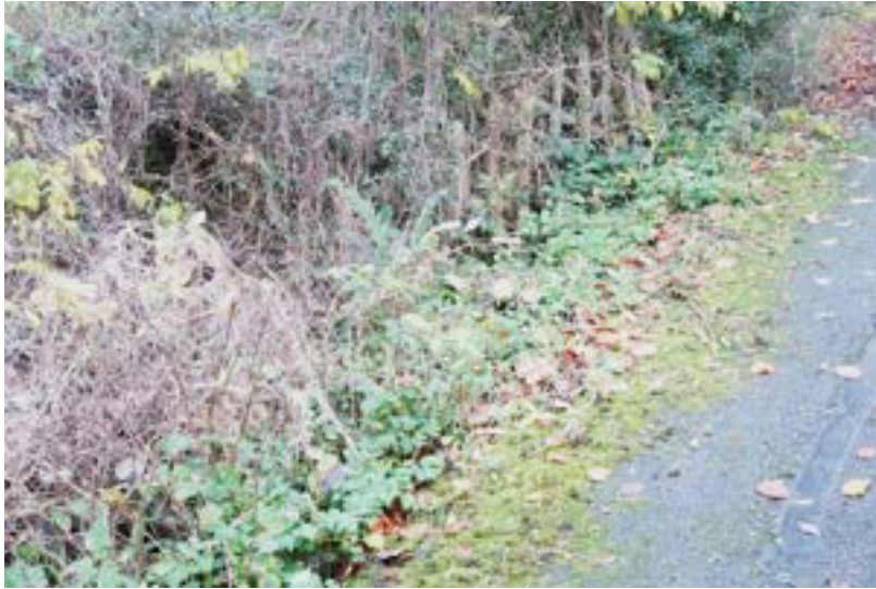
Maroder Jägerzaun an nördlicher Grundstücksgrenze
