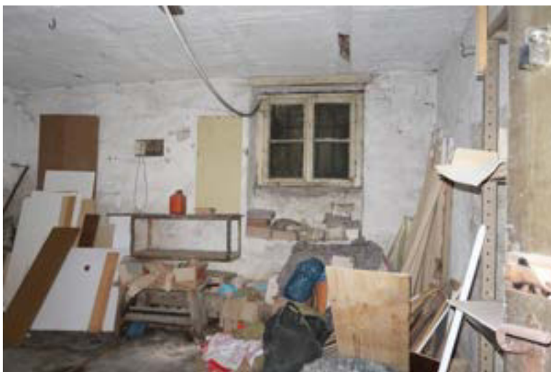
Lagerraum im Keller
