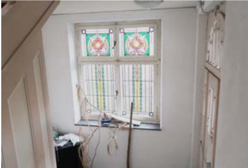
Fenster im Treppenhaus - Eingangsbereich
