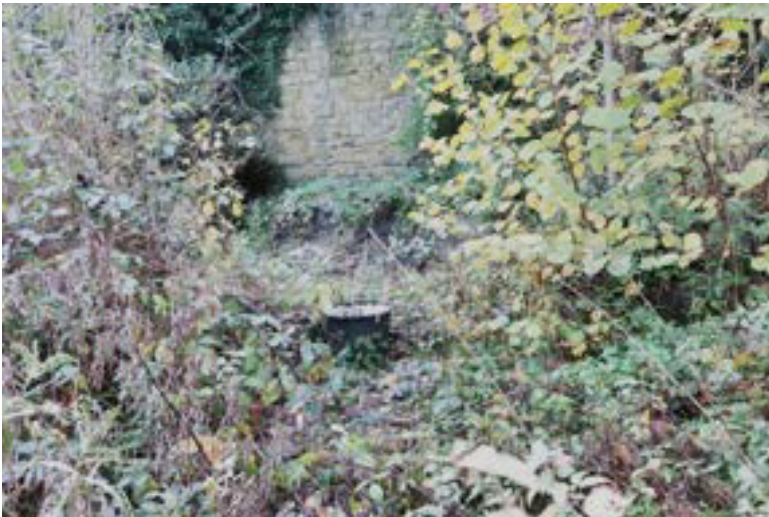
Im Bildhintergrund die Stützmauer zur Geländeabfangung an der westlichen Grundstücksgrenze (Bismarckstr. 12 a), davor die zweite Terrasse.
