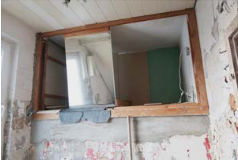
Hohlraum oberhalb Waschbeckeninstallation
