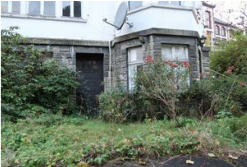
Separater Zugang zum Bürobereich im Untergeschoss durch den Vorgarten.
