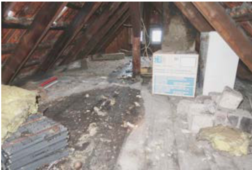
Spitzboden mit Wasserlache
