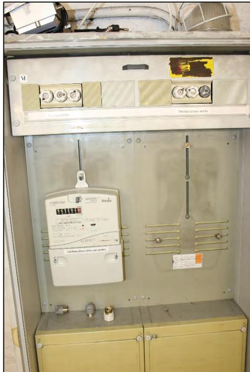
Foto Nr. 13: Kellergeschoss, Elektrounterverteilung für das Dachgeschoss
