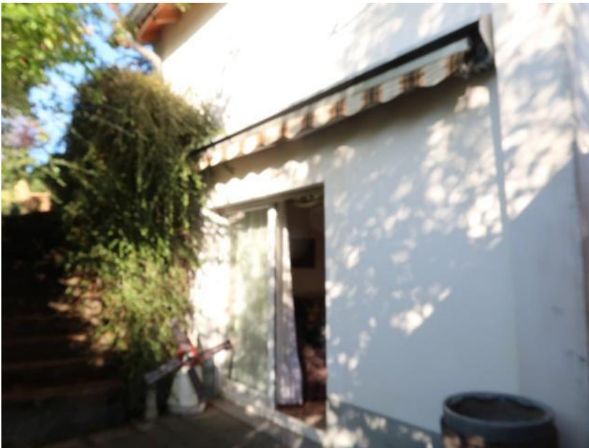
Südliche Traufseite des Gebäudes mit Zugang zur Terrasse aus der hier zu bewertenden Wohnung Nr. 1.
