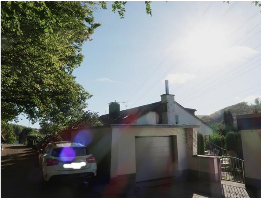
Westliche Giebelwand des Gebäudes, vorgelagert die Garage (zu Wohnung Nr. 3 mit Terrasse auf dem Garagendach)
