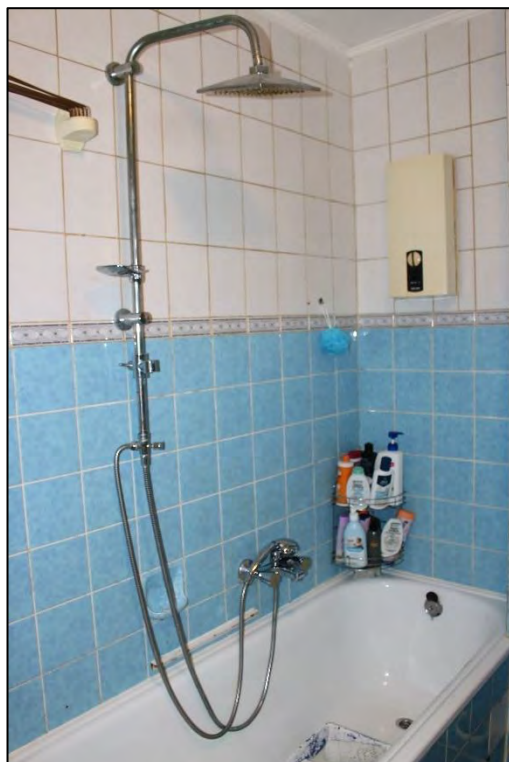
Foto Nr. 104: WE Nr. 18, 5. OG mittig, Bad
