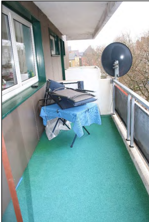
Foto Nr. 95: WE Nr. 16, 4. OG hinten links, Balkon – Foto vom 10.02.2022
