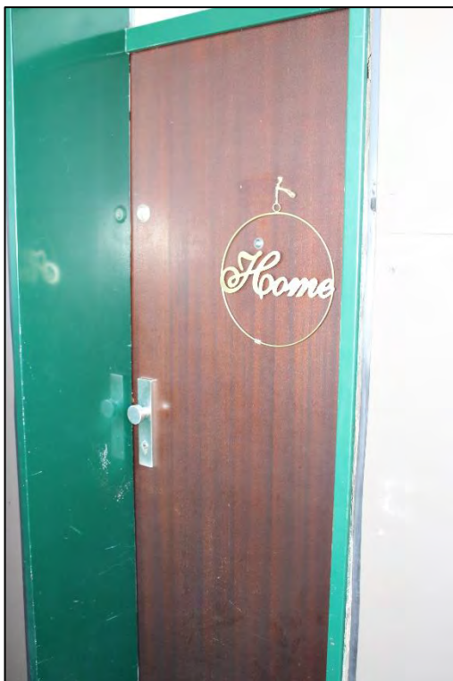
Foto Nr. 98: WE Nr. 17, 5. OG rechts, Eingang
