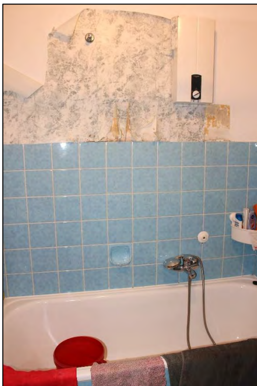
Foto Nr. 106: WE Nr. 19, 5. OG links, Bad
