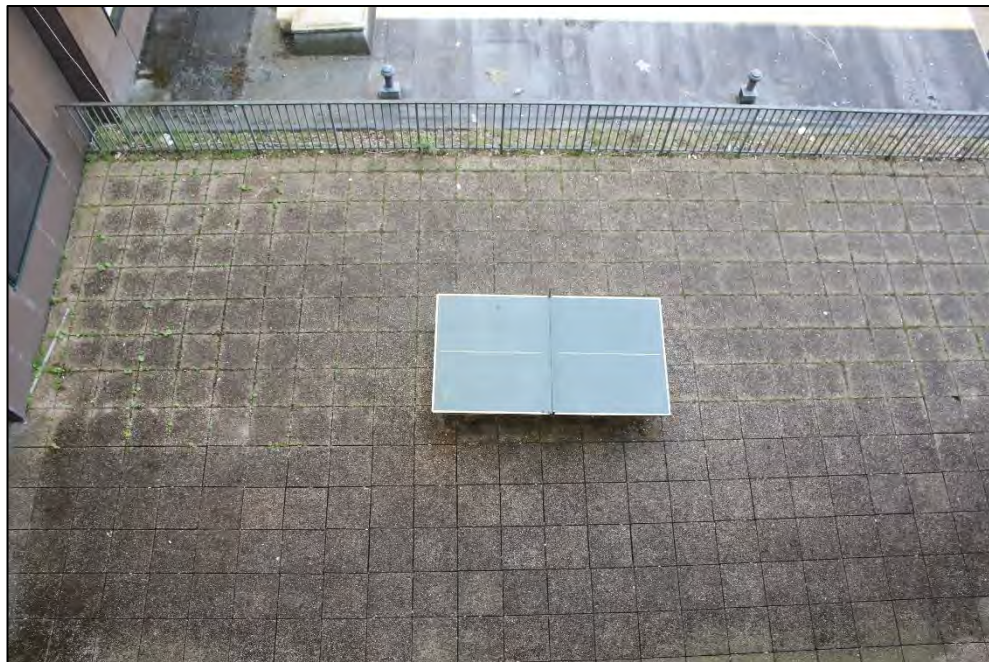
Foto Nr. 85: Flachdach über dem Erdgeschoss
