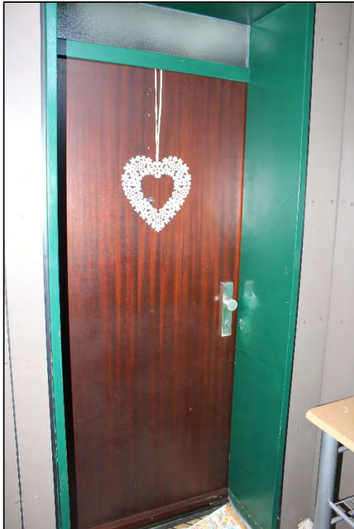
Foto Nr. 41: WE Nr. 4, 1. OG hinten links, Eingang
