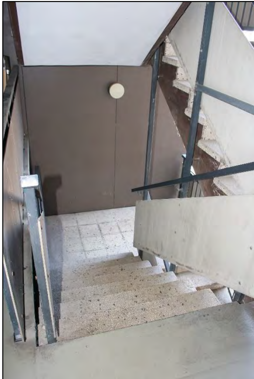
Foto Nr. 73: Außentreppe
