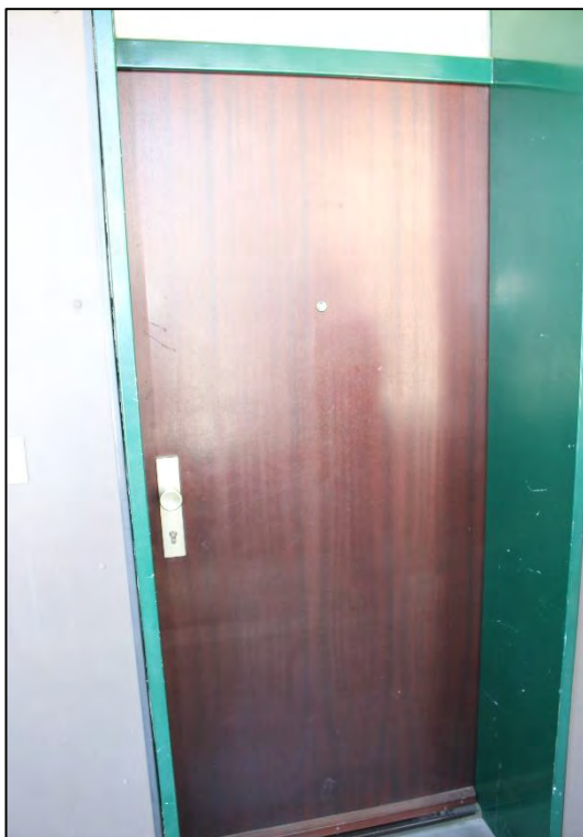
Foto Nr. 84: WE Nr. 14, 4. OG mittig, Eingang
