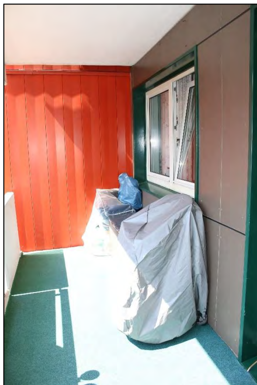
Foto Nr. 50: WE Nr. 6, 2. OG mittig, Balkon
