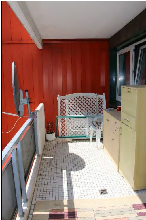
Foto Nr. 69: WE Nr. 10, 3. OG mittig, Balkon
