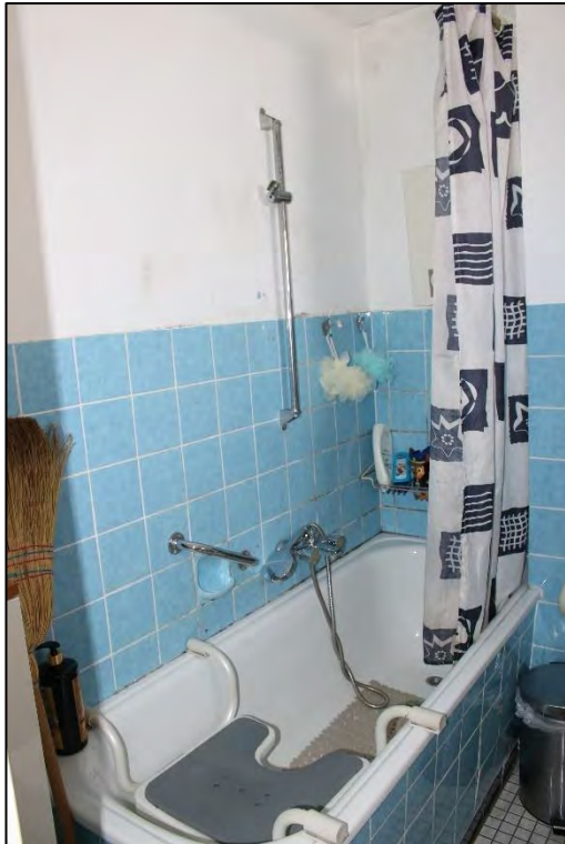
Foto Nr. 71: WE Nr. 10, 3. OG mittig, Bad
