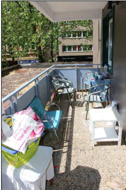
Foto Nr. 37: WE Nr. 3, 1. OG links, Terrasse
