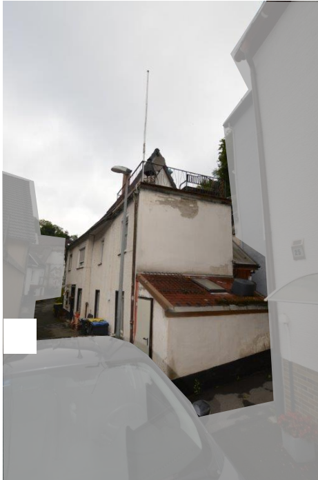
Rechte Seite mit eingeschossigem Anbau
