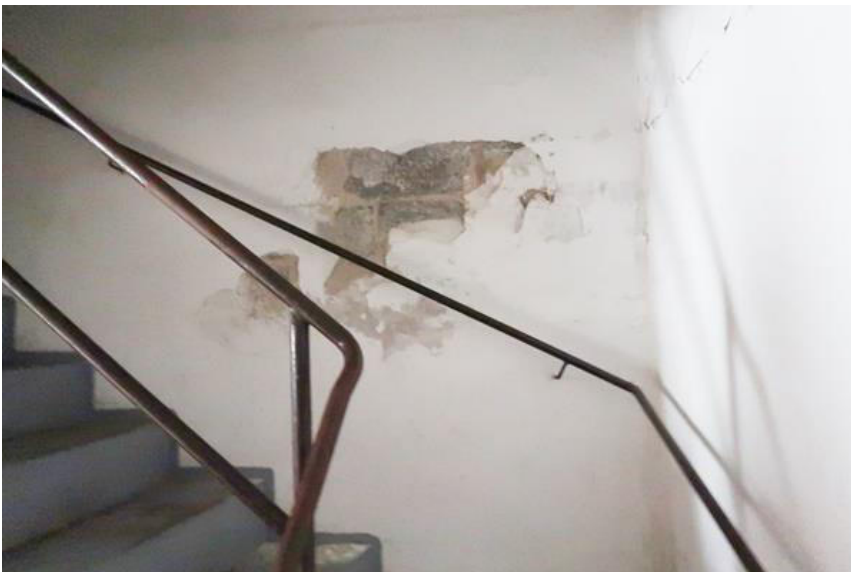
Großflächige Putzabplatzung
