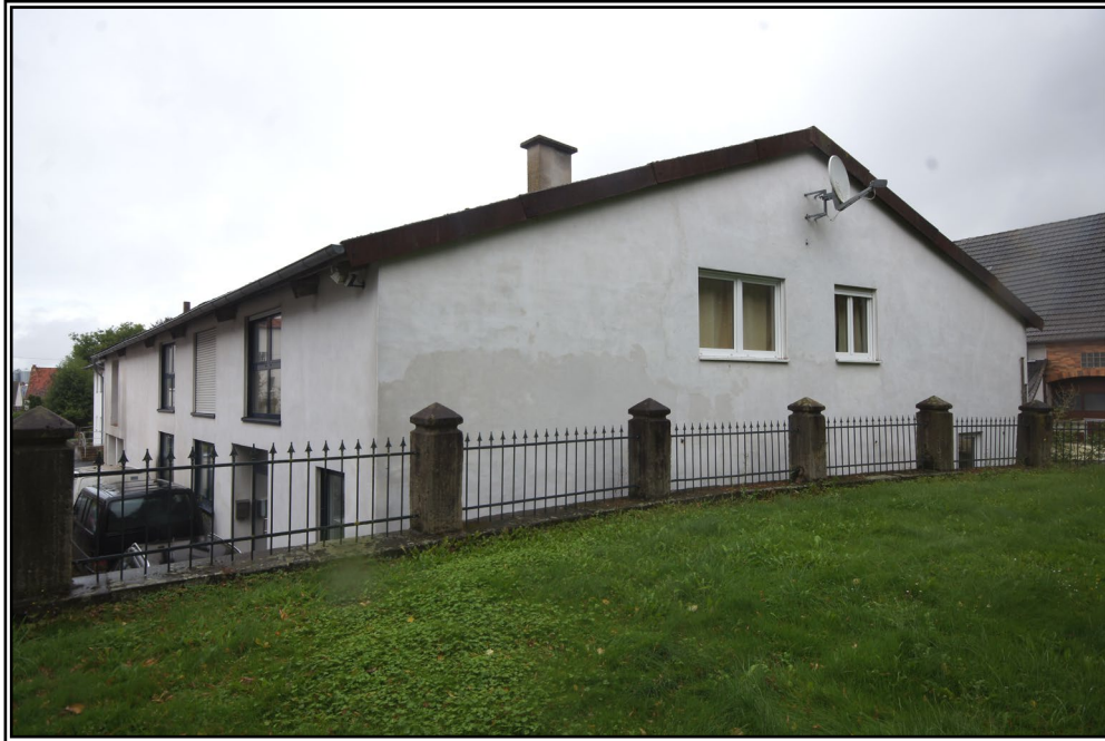
Rückwärtige Ansicht von Süden
