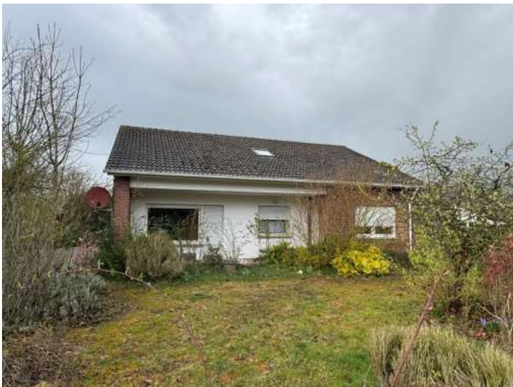
Ansicht von Süden (Straße)
