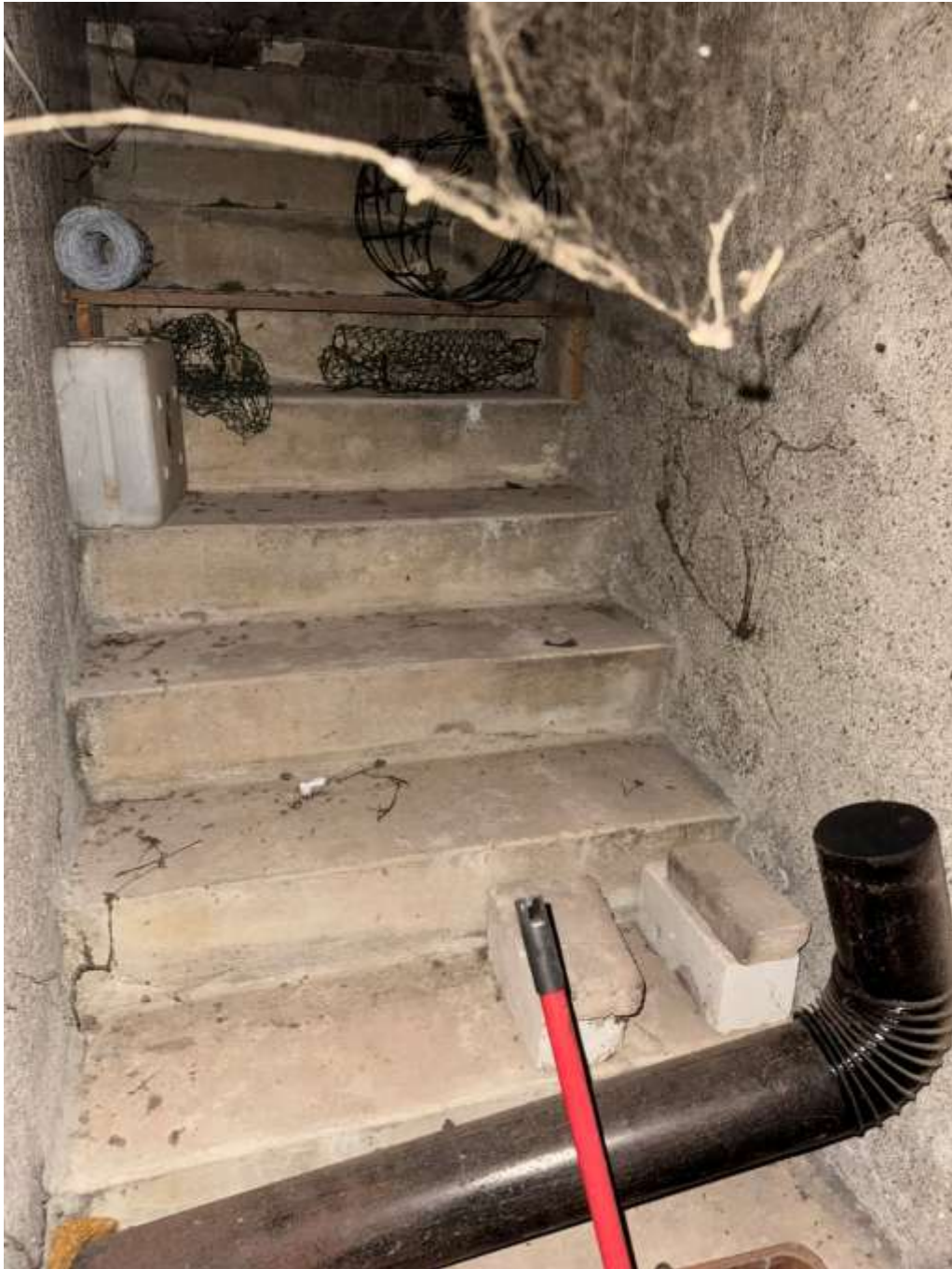
Stillgelegte Kelleraußentreppe (durch übergebauete Terrasse)
