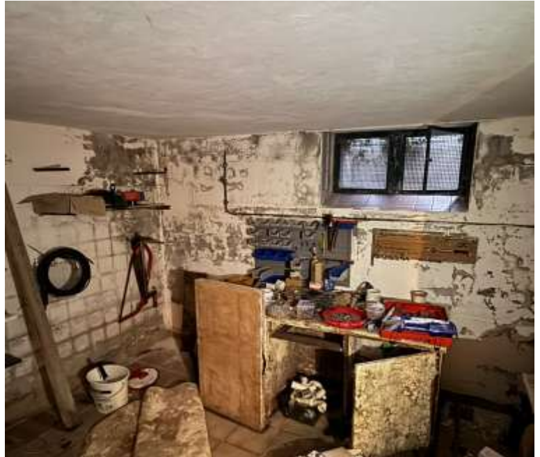
Durchfeuchtete Kelleraußenwände
