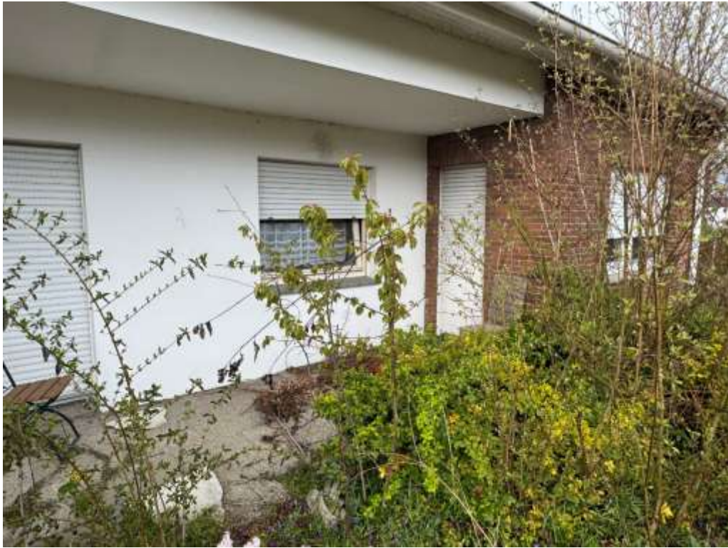
Terrasse auf der Südseite
