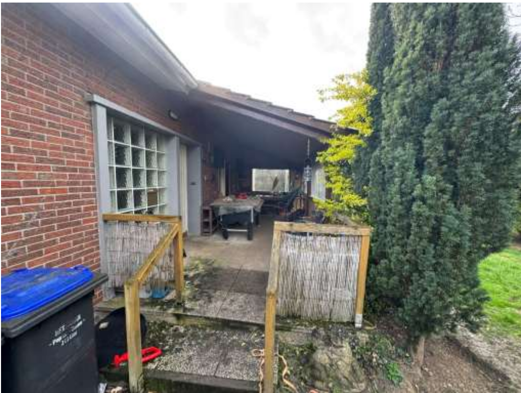
Hauseingang und überdachte Terrasse auf der Nordseite
