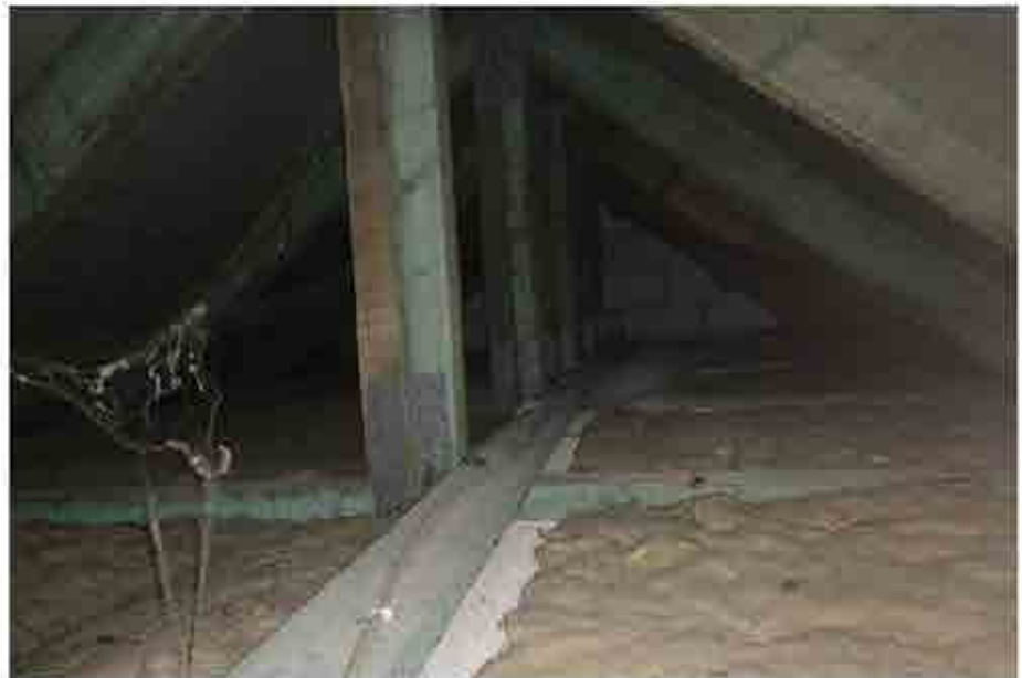
Blick auf den Spitzboden (Foto aus dem Gutachten vom 24. März 2023)
