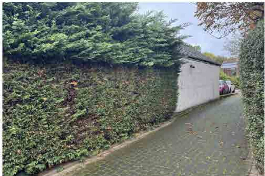
Zufahrt Hinterbebauung, Ansicht der Gartenseite und der Garage von Nordosten (Foto vom 17. Oktober 2025)
