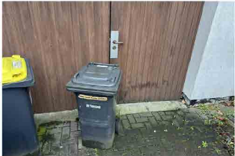
Detail Garagentür (Foto vom 17. Oktober 2025)
