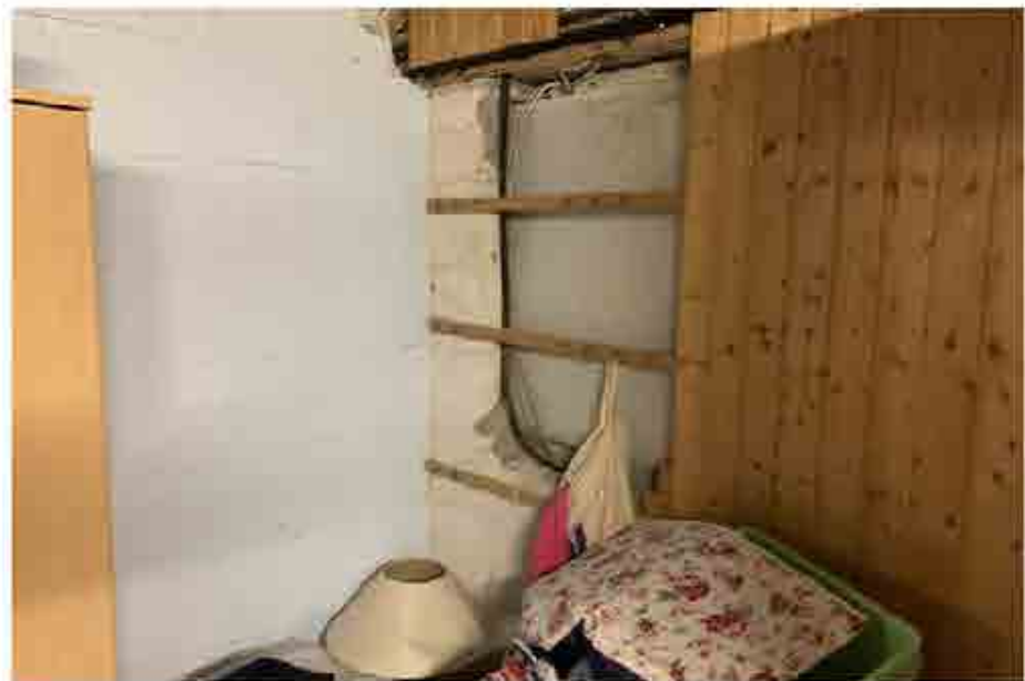
KG, Hobby, Detail Wand (Foto aus dem Gutachten vom 24. März 2023)
