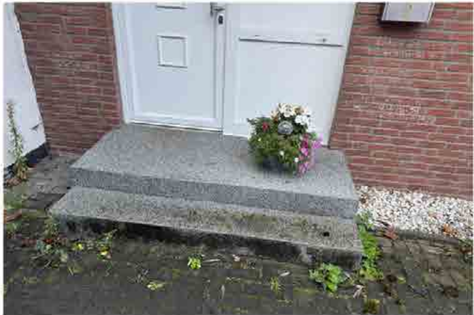
Eingangsbereich (Foto vom 17. Oktober 2025)
