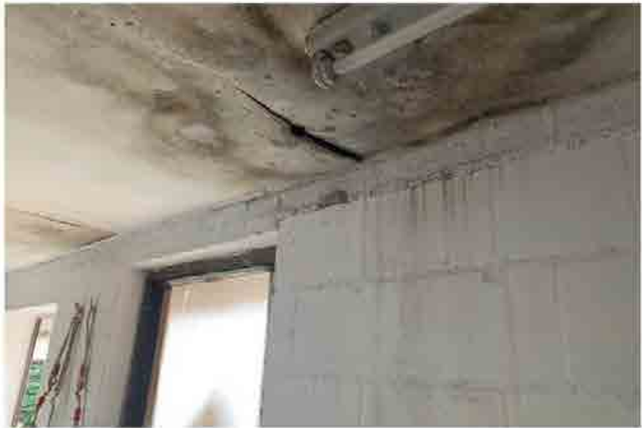
Garage Innenraum, Detail Decke (Foto aus dem Gutachten vom 24. März 2023)
