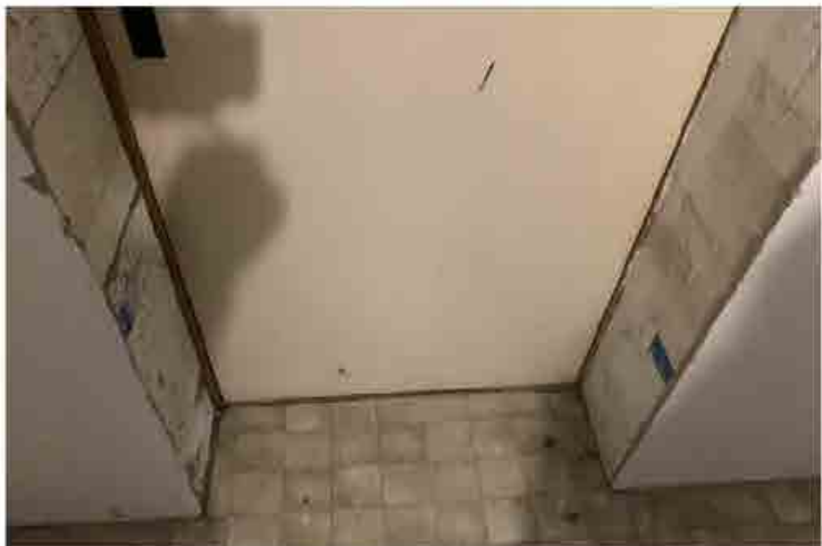
KG, Zugang zum Raum Hobby (Foto aus dem Gutachten vom 24. März 2023)
