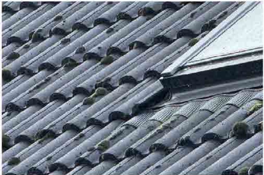
Detail Dach (Foto vom 17. Oktober 2025)
