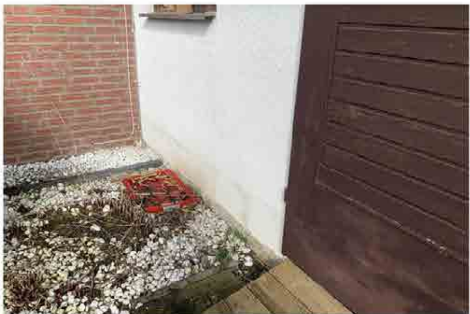
Detail Garagenaussenwand, Ansicht von Südosten (Foto aus dem Gutachten vom 24. März 2023)
