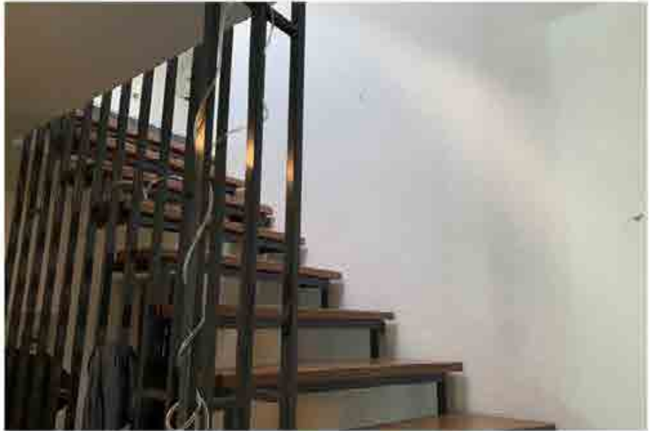
EG, Treppe zum DG (Foto aus dem Gutachten vom 24. März 2023)
