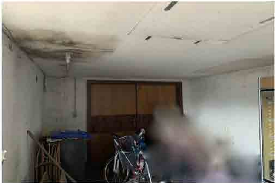
Garage Innenraum (Foto aus dem Gutachten vom 24. März 2023)
