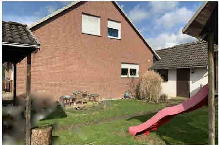
Gartenseite, Ansicht von Südosten (Foto aus dem Gutachten vom 24. März 2023)
