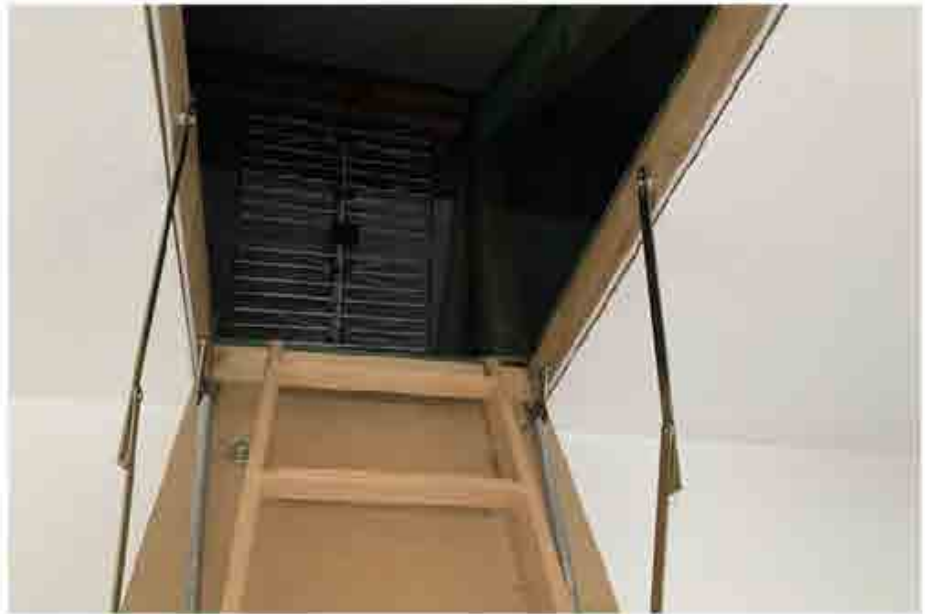
DG, Zugang zum Spitzboden (Foto aus dem Gutachten vom 24. März 2023)
