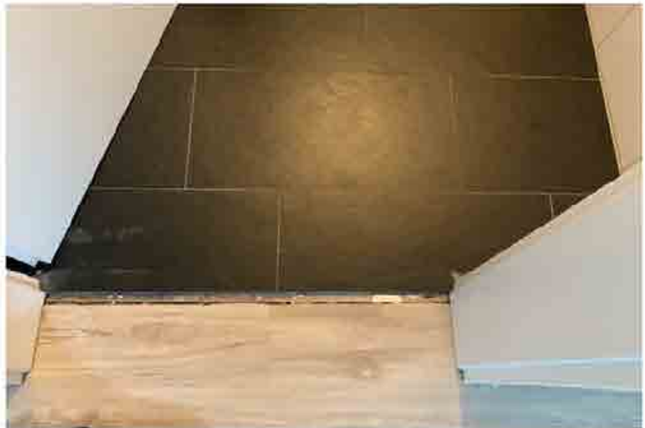
DG, Zugang zum Bad (Foto aus dem Gutachten vom 24. März 2023)
