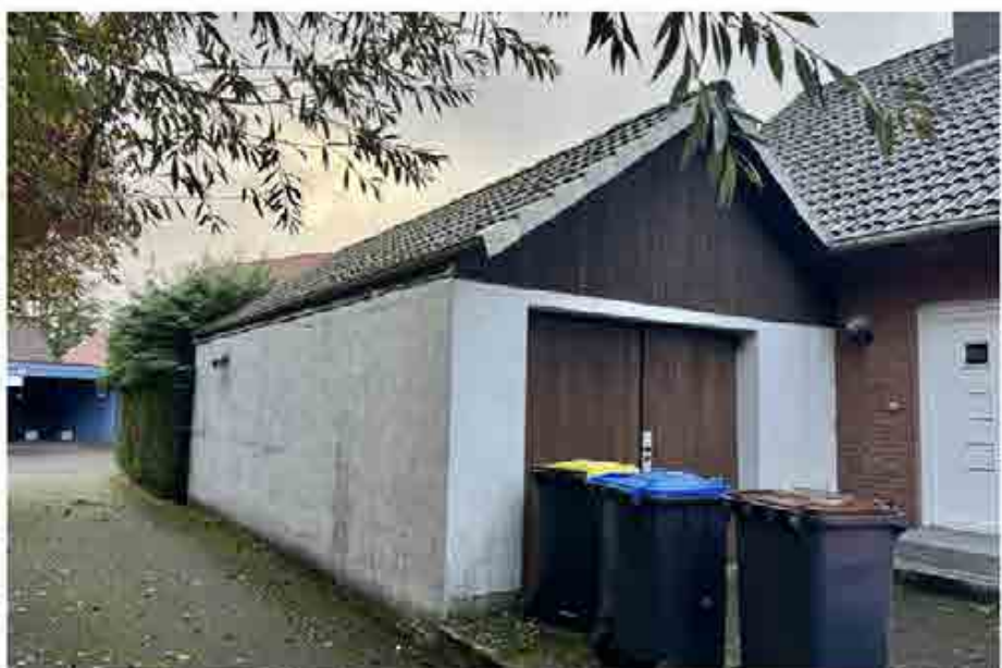
Garage, Ansicht von Norden (Foto vom 17. Oktober 2025)
