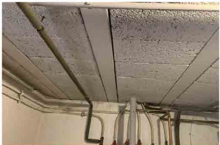
Decke über KG, Heizen/Waschen/ Trocknen (Foto aus dem Gutachten vom 24. März 2023)
