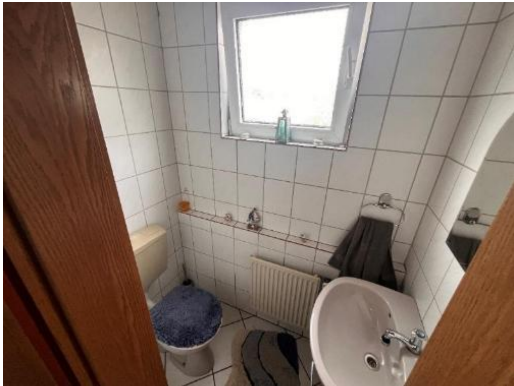
Gewerbehalle: Büro WC
