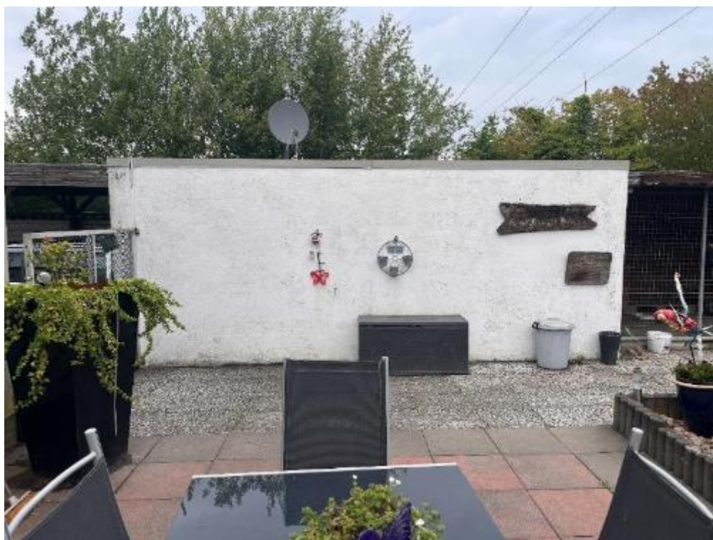
Außenansicht Terrasse (Hinter Gewerbehalle)
