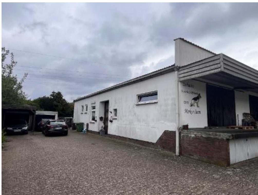
Außenansicht (Hof und Garagen)
