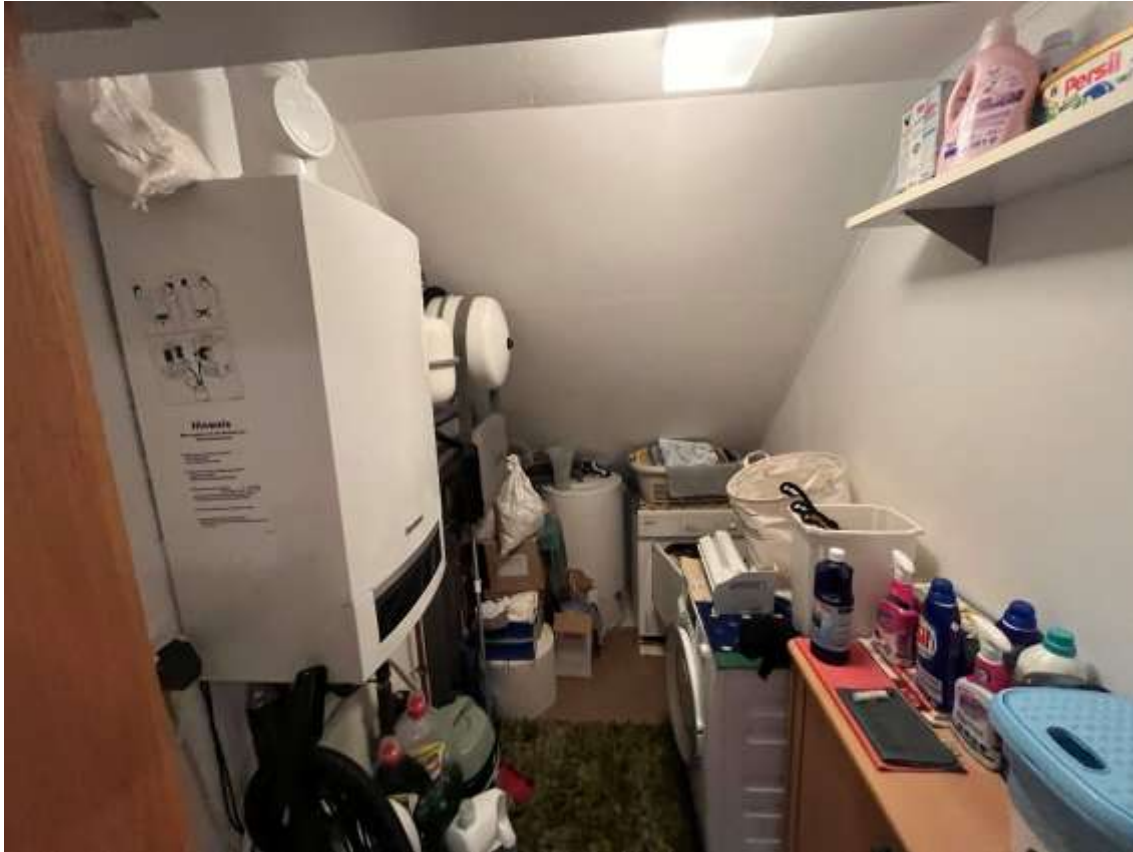
Abstell- und Technikraum
