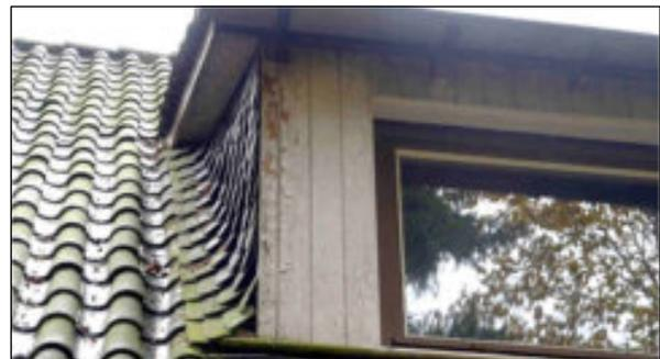
Bild 92: Unterhaltungsstau/Schäden
