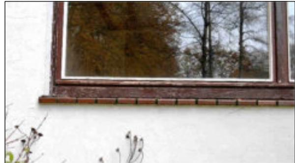
Bild 90: Unterhaltungsstau/Schäden
