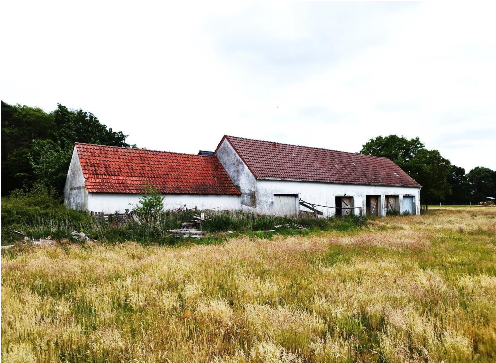
Bild 1 Ansicht von Westen
