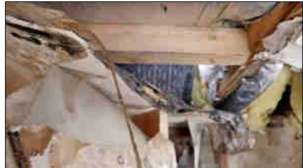
Bild 54: Unterhaltungstau/Schäden (Beispiel)
