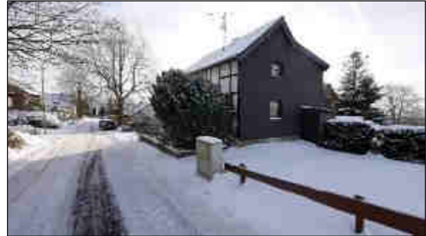
Bild 2: Blick in die Erschließungsstraße mit Bewertungsobjekt
