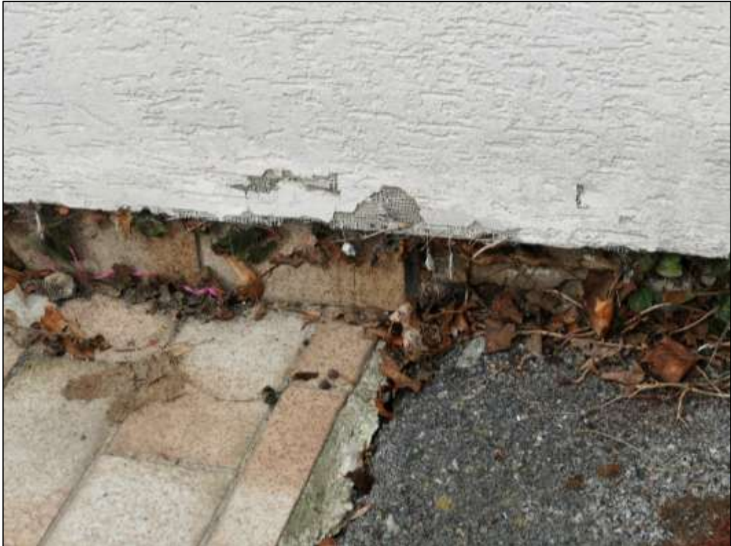
Putzschäden Sockel
