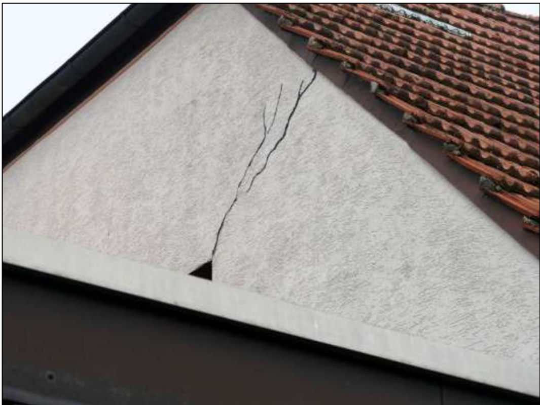
Fassadenriss Dachgiebel
