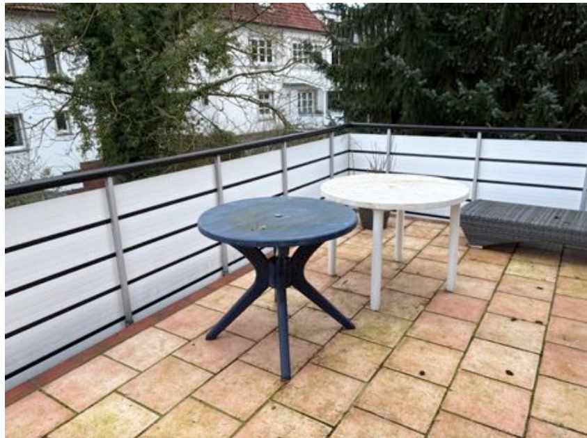
Balkon im Obergeschoß
