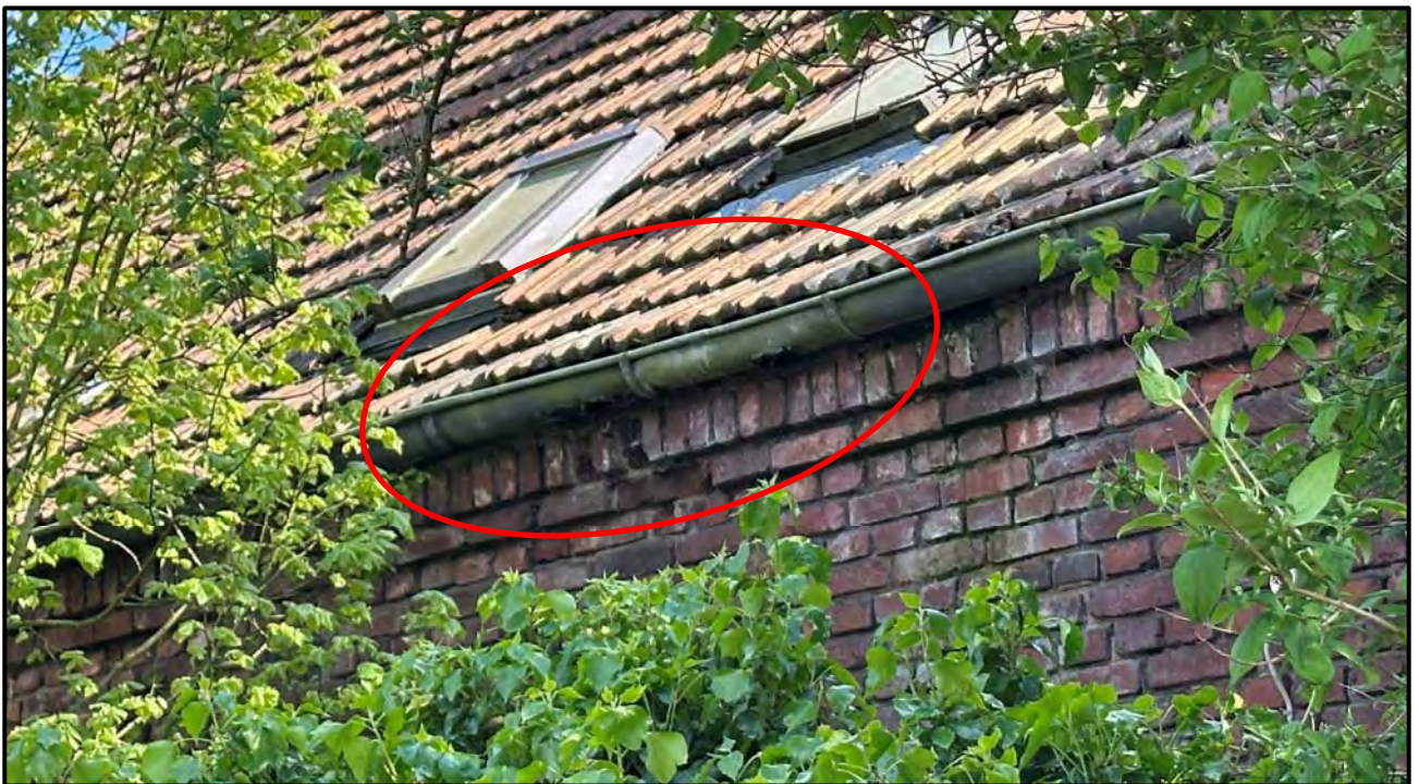
mangelhafte Dachentwässerung
