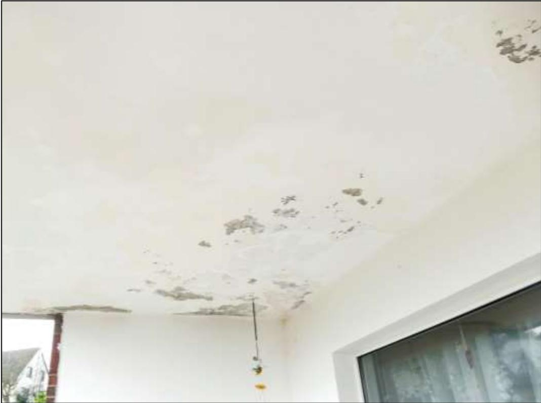
Feuchtigkeitsschäden im Bereich der Balkone
