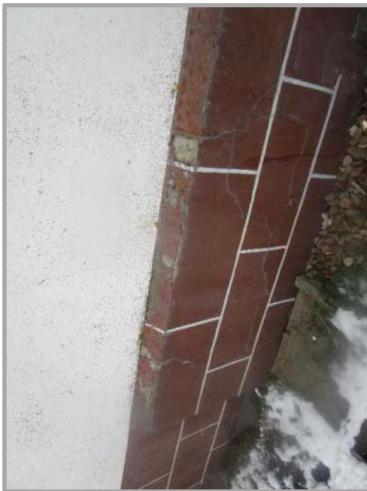
Fassadenkante, schadhaft
