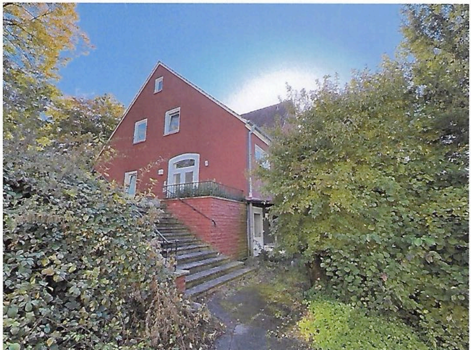
Nordansicht des Gebäudeteils Nr. 252, Hauseingang
