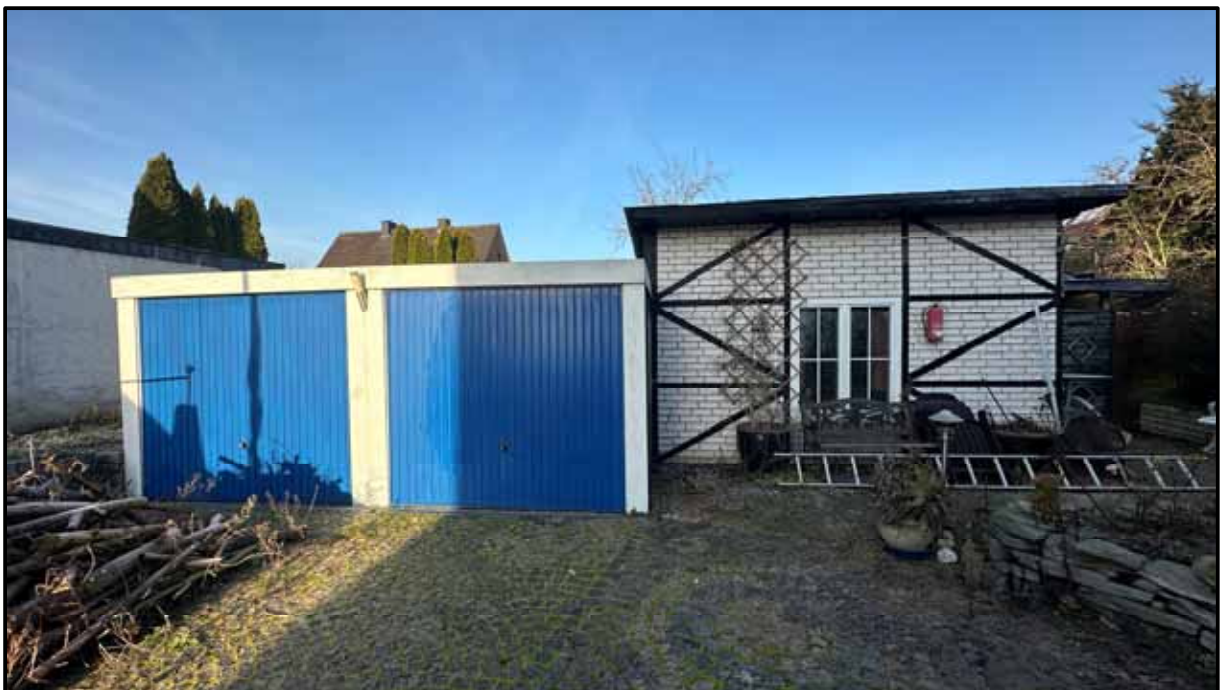
PKW-Doppelgarage und baufälliges Nebengebäude
