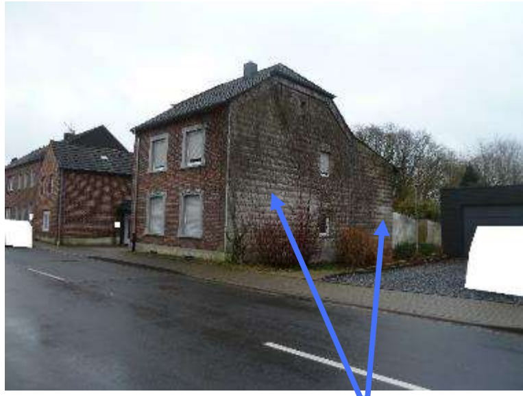
Fassade westliche Giebelseite mit Eternitplattenverkleidung (Altbau und Anbau)
