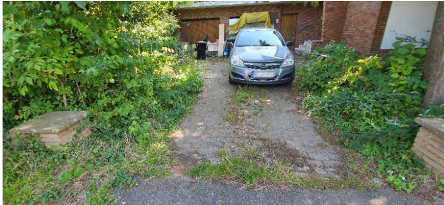
Detailfoto der nordöstlich vom Gebäude befindlichen Grundstückszufahrt
