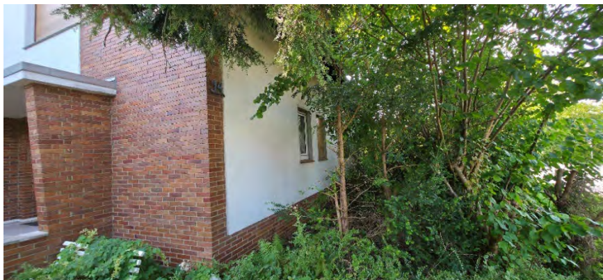
Gebäudeteilansicht des Gebäudes von Nordosten
