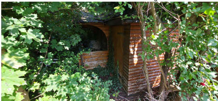
Detailfoto einer baulichen Anlage im südlich ausgerichteten Gartenteil
