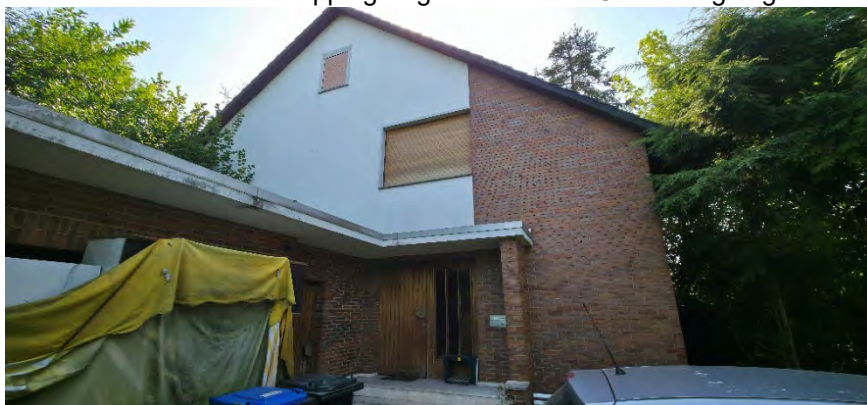
Gebäudeansicht von Osten
