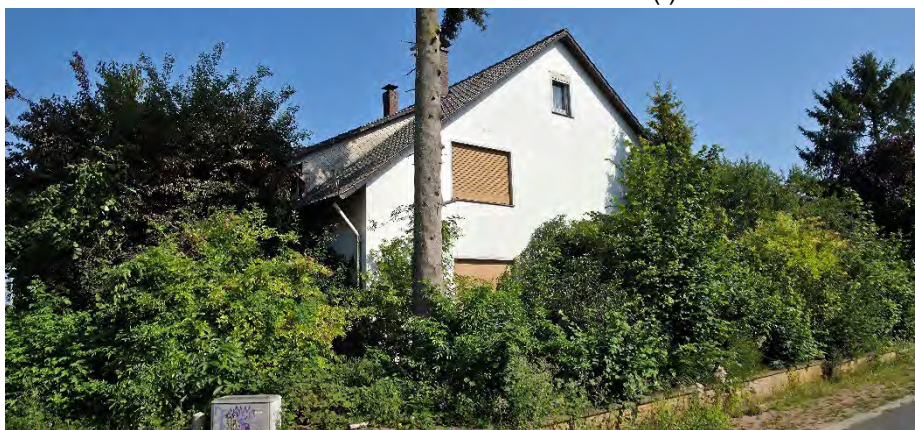
Gebäudeansicht von Nordwesten (II)
