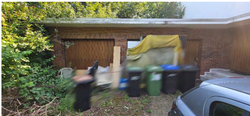
Detailansicht der Doppelgarage östlich vom Gebäude gelegen
