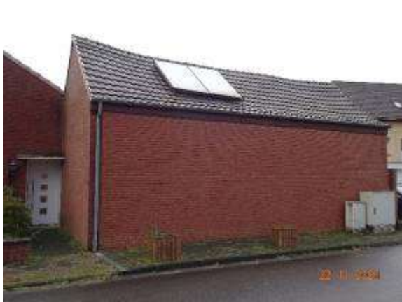
Nebengebäude (Schuppen) Strassenseitig
