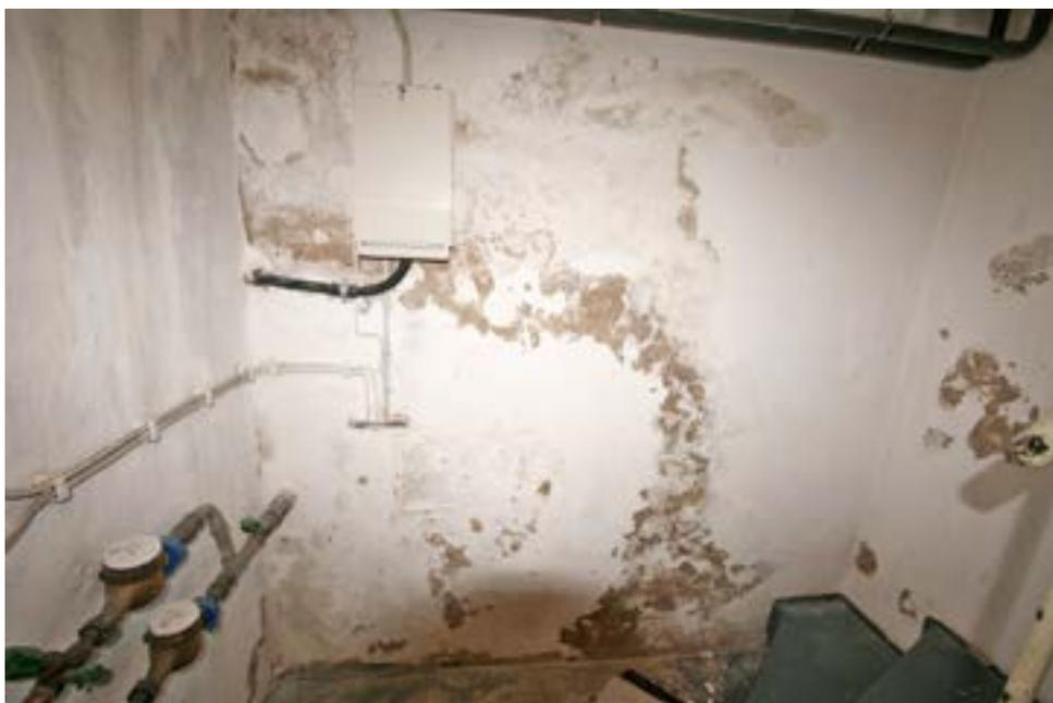
Bild 8: Feuchtigkeitsschaden an Kelleraußenmauerwerk (2)
