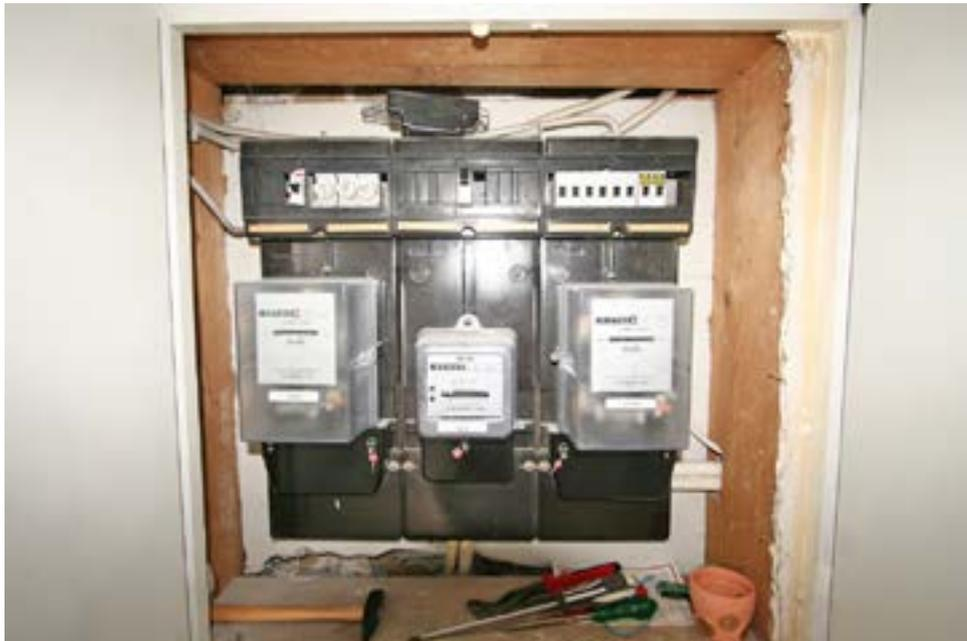
Bild 9: Überalterte Elektro-Unterverteilung
