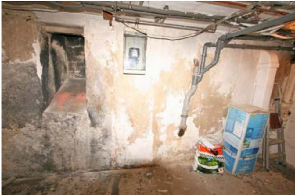
Bild 7: Feuchtigkeitsschaden an Kelleraußenmauerwerk (1)
