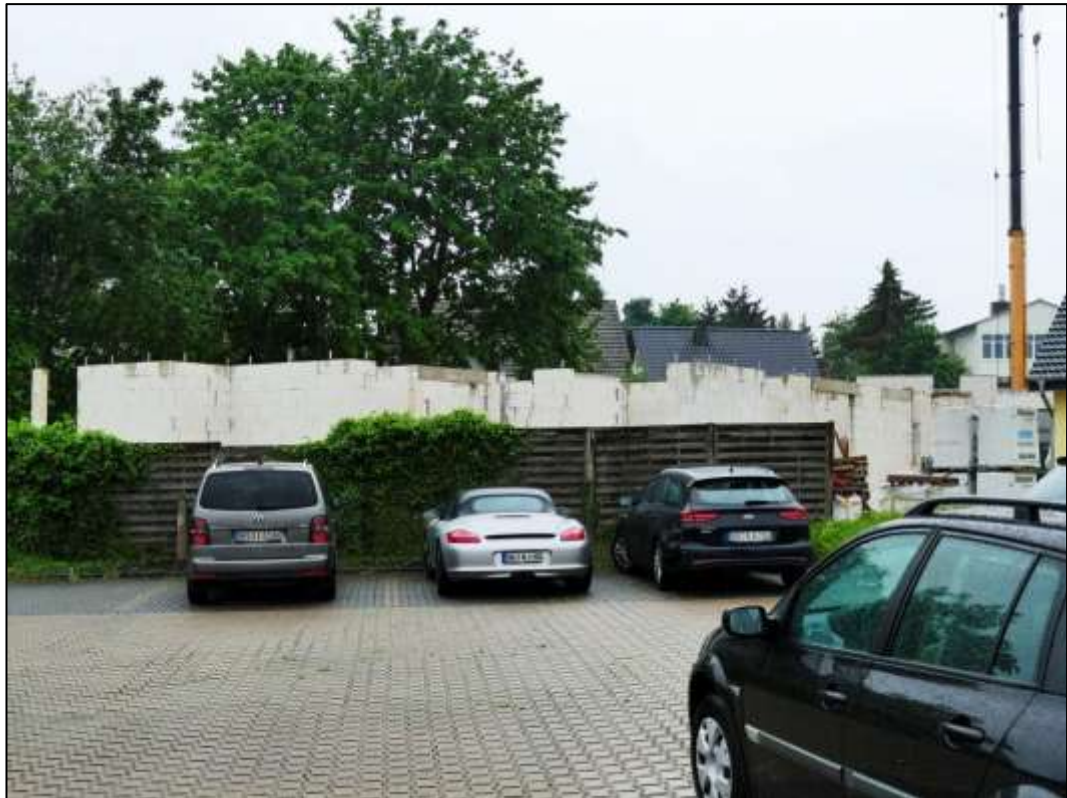
Rohbau Haus Königstraße 37: Nord-Ansicht
