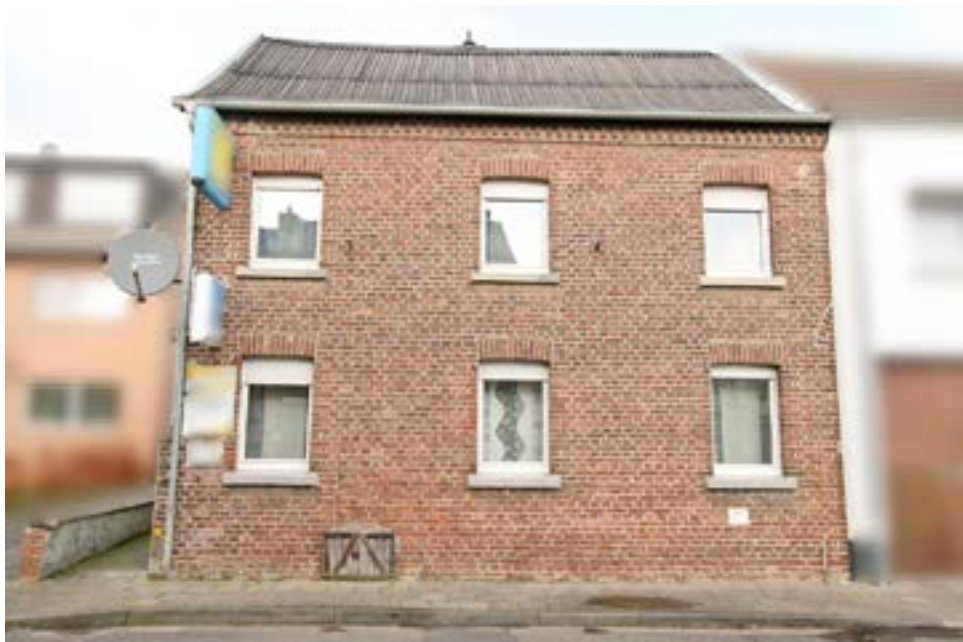
Bild 2: Straßenansicht des Wohnhauses aus südlicher Richtung
