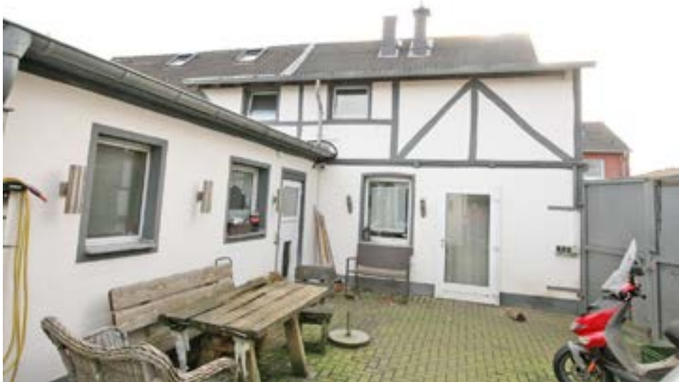
Bild 3: Rückansicht des Wohnhauses und Seitenansicht des eingeschossigen Anbaus mit zur Werkstatt gehörendem Kunden-WC und WC-Vorraum aus nordwestlicher Richtung
