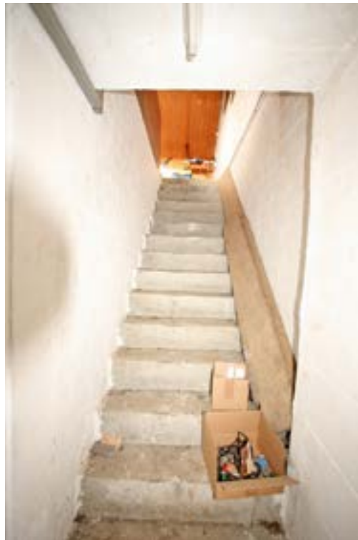
Bild 15: Treppe zum Dachgeschoss der Werkstatt
