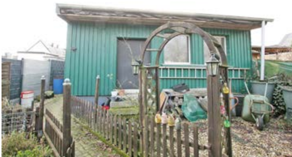
Bild 8: Rückansicht des Gebäudes zur Erweiterung der Werkstatt (ohne Genehmigung errichtet) aus nördlicher Richtung
