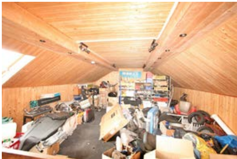
Bild 16: Dachgeschoss der Werkstatt
