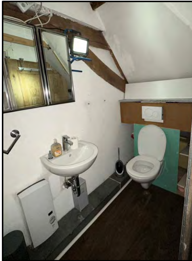
WC im Dachgeschoss
