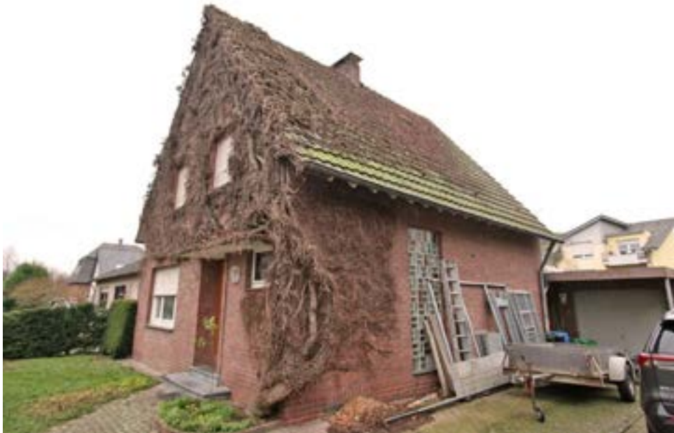
Bild 1: Ansicht des Bewertungsobjekts aus östlicher Richtung
