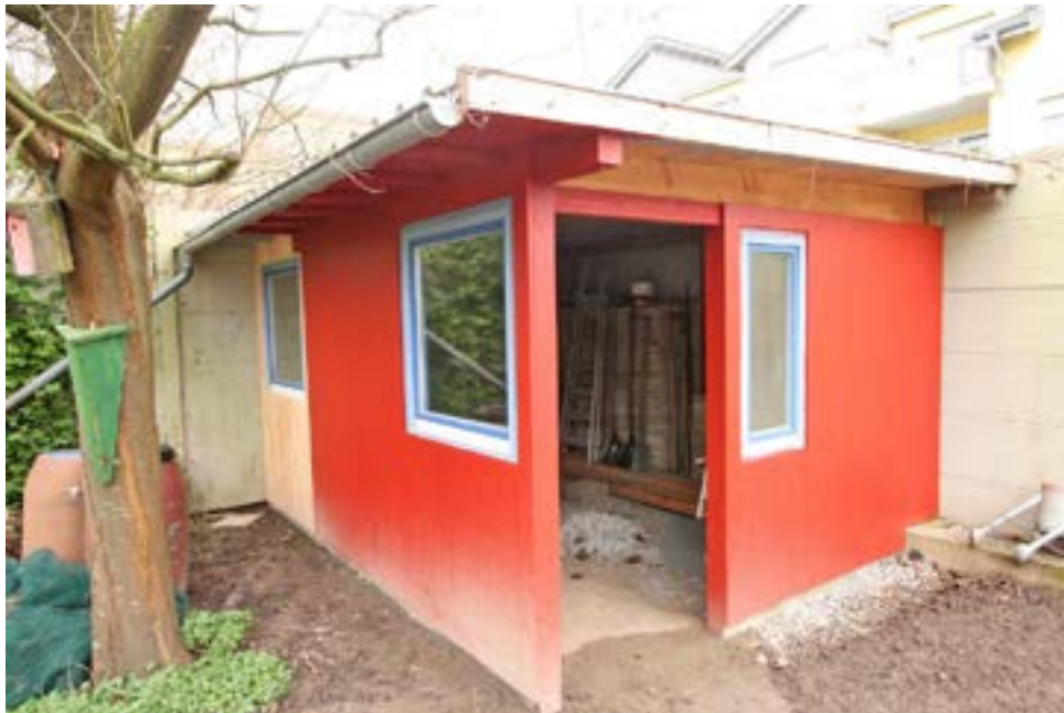
Bild 13: noch nicht fertiggestellter Holzschuppen
