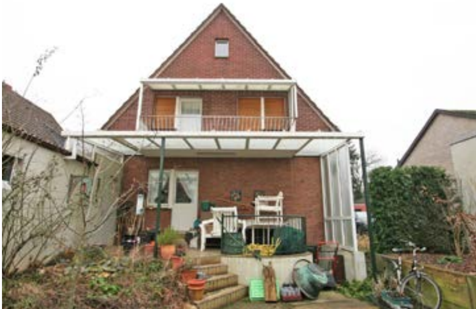
Bild 4: Rückansicht des Bewertungsobjekts aus nordwestlicher Richtung
