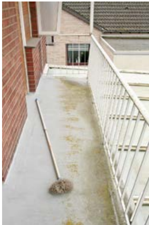
Bild 8: Balkon im Dachgeschoss des Bewertungsobjekts
