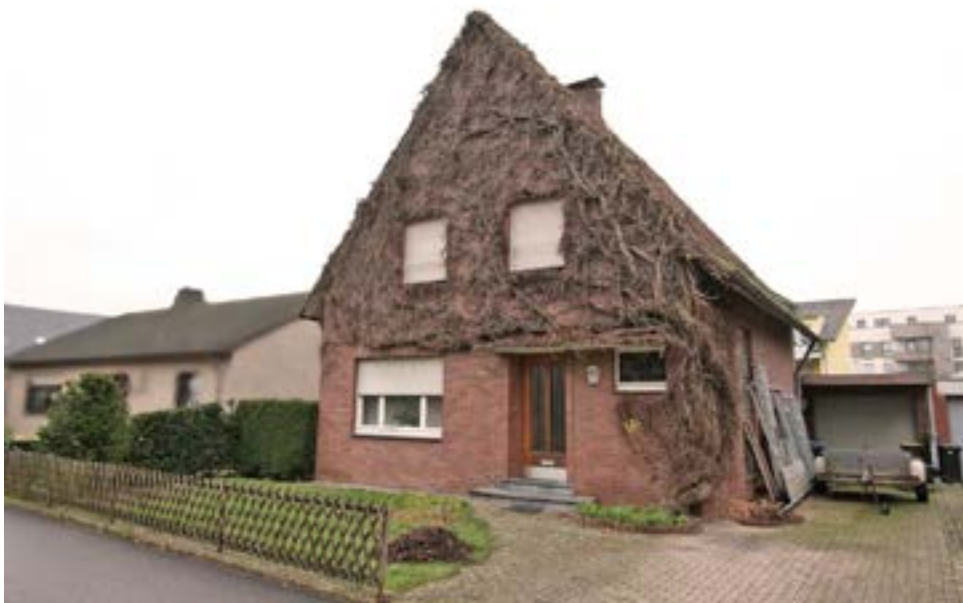
Bild 2: Straßenansicht des Bewertungsobjekts aus südöstlicher Richtung
