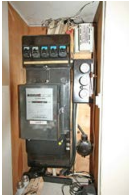
Bild 11: Überalterte Elektroverteilung
