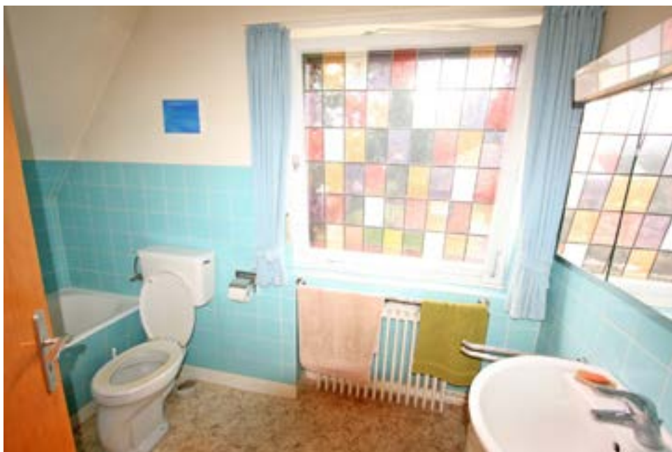
Bild 6: Badezimmer im Dachgeschoss des Bewertungsobjekts
