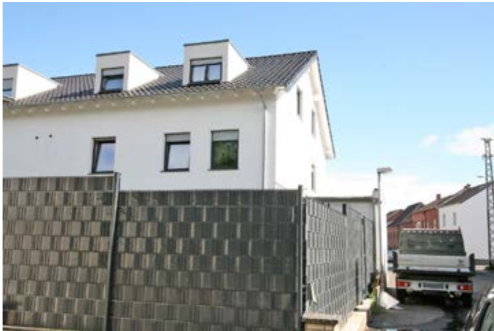
Bild 3: Rückansicht des Bewertungsjekts aus südwestlicher Richtung
