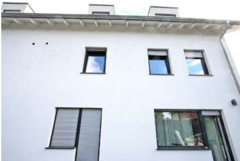
Bild 4: Rückansicht des Zweifamilienhauses aus südwestlicher Richtung
