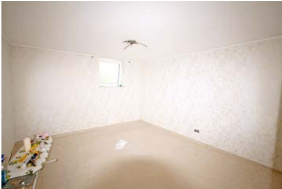
Bild 7: Ausbau- oder Instandsetzungsarbeiten im Keller 2 im Kellergeschoss des Bewertungsobjekts
