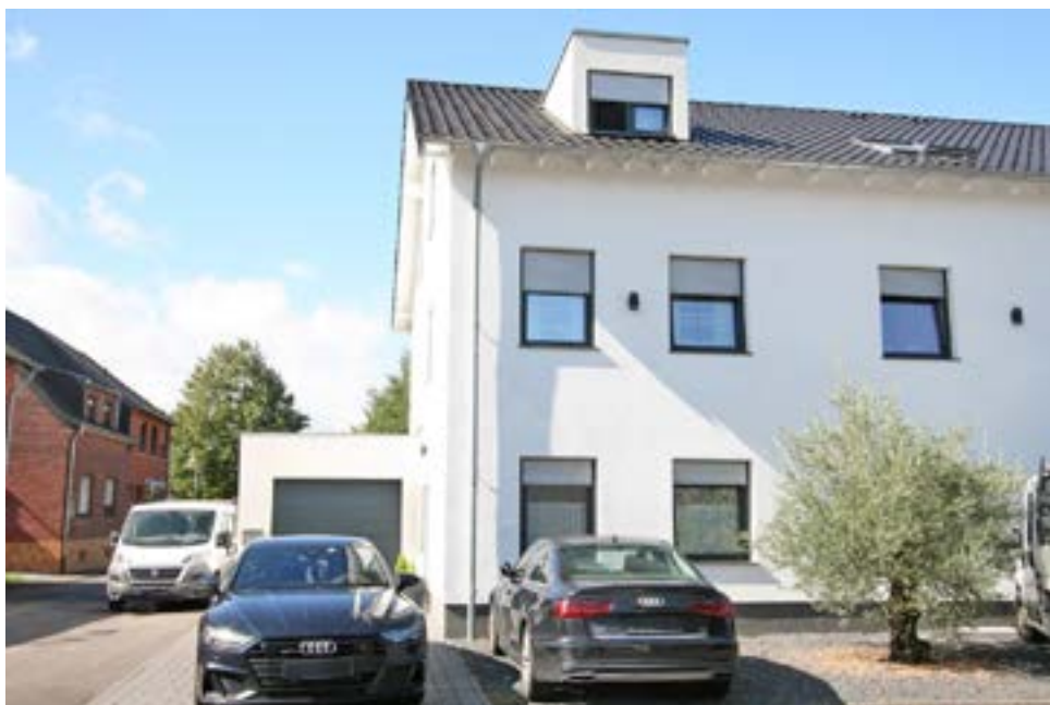
Bild 2: Straßenansicht des Bewertungsobjekts aus nordöstlicher Richtung
