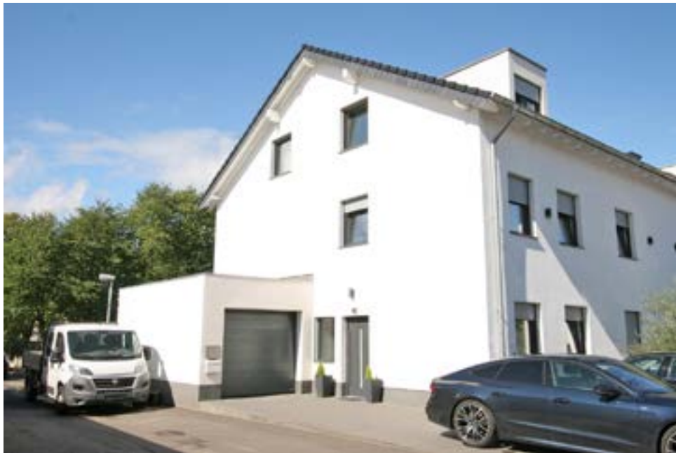
Bild 1: Straßenansicht des Bewertungsobjekts aus östlicher Richtung
