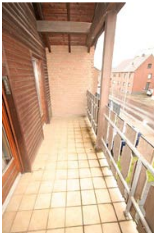
Bild 12: Loggia im Dachgeschoss des Bewertungsobjekts
