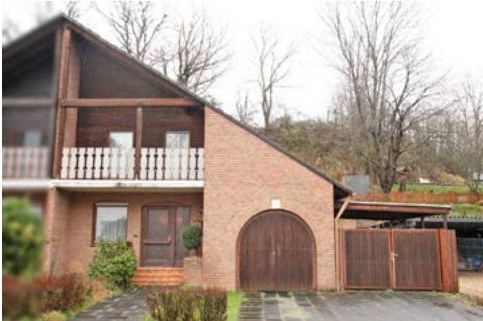
Bild 1: Straßenansicht des Bewertungsobjekts aus nordwestlicher Richtung
