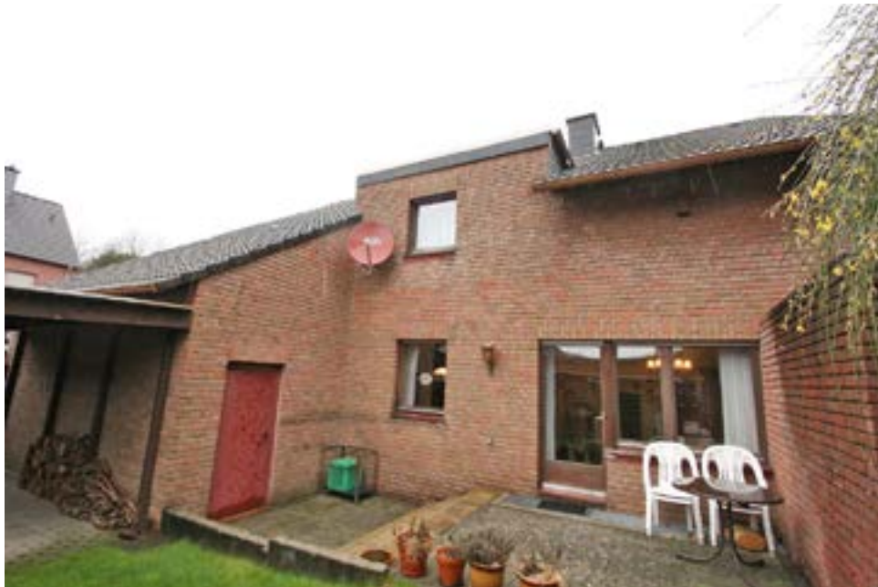
Bild 3: Seitenansicht des Bewertungsobjekts aus südlicher Richtung
