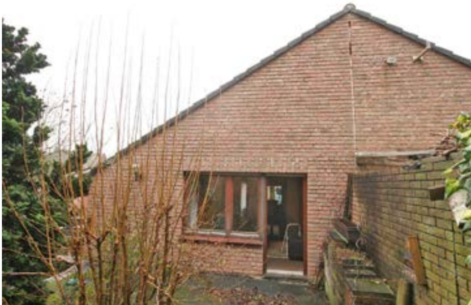
Bild 6: Rückansicht des Dachgeschosses des Bewertungsobjekts aus östlicher Richtung von der im Südosten vor dem Schlafzimmer gelegenen Terrasse
