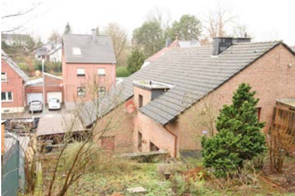
Bild 7: Rückansicht des Bewertungsobjekts aus südöstlicher Richtung
