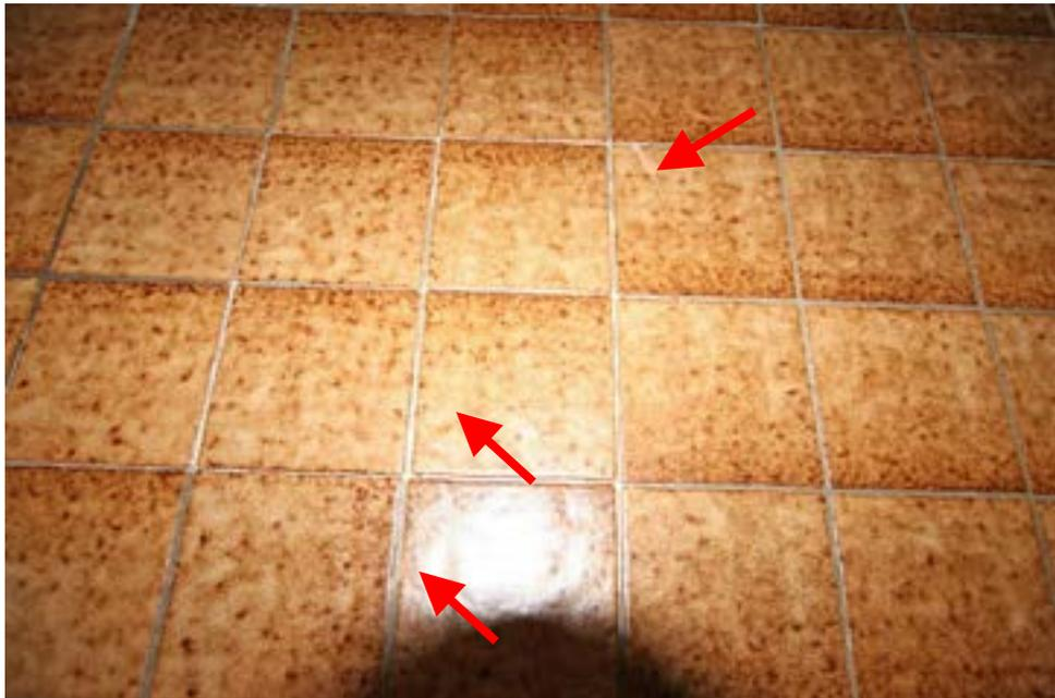
Bild 15: Schadhafter Fliesenbelag im Erdgeschoss (1)
