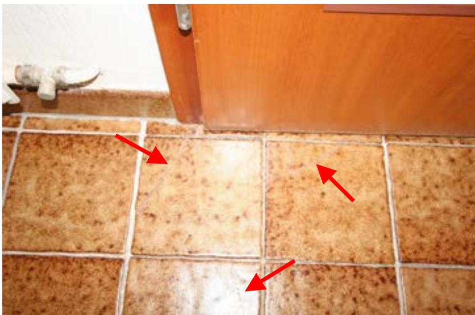
Bild 16: Schadhafter Fliesenbelag im Erdgeschoss (2)
