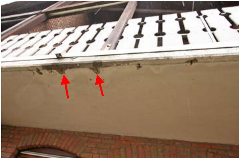
Bild 17: Betonabplatzungen an Balkonplatte
