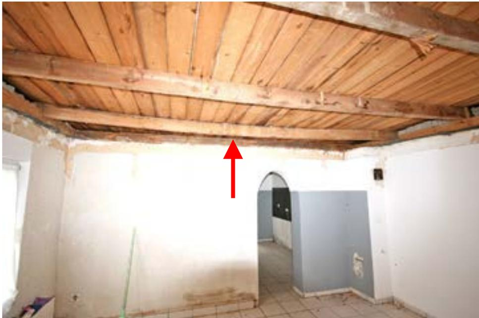
Bild 13: Zimmer im Anbau des Bewertungsobjekts, mindestens ein Deckenbalken hängt durch
