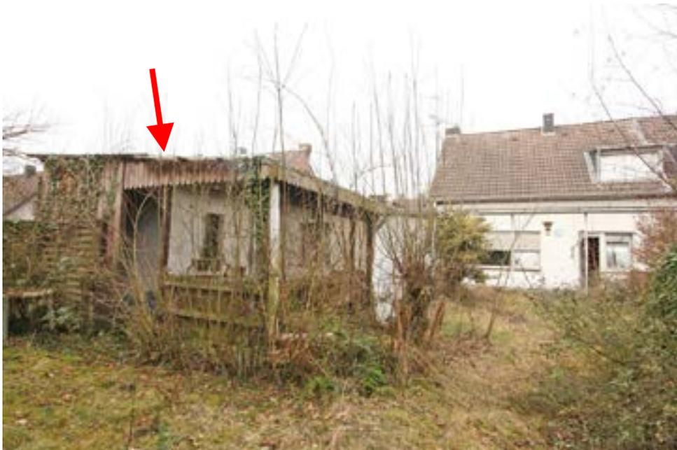
Bild 4: Rückansicht des Bewertungsobjekts aus östlicher Richtung, im Vordergrund ist der Teil des Anbaus mit Holzüberdachung zu sehen, der wohl ohne baurechtliche Erlaubnis errichtet wurde
