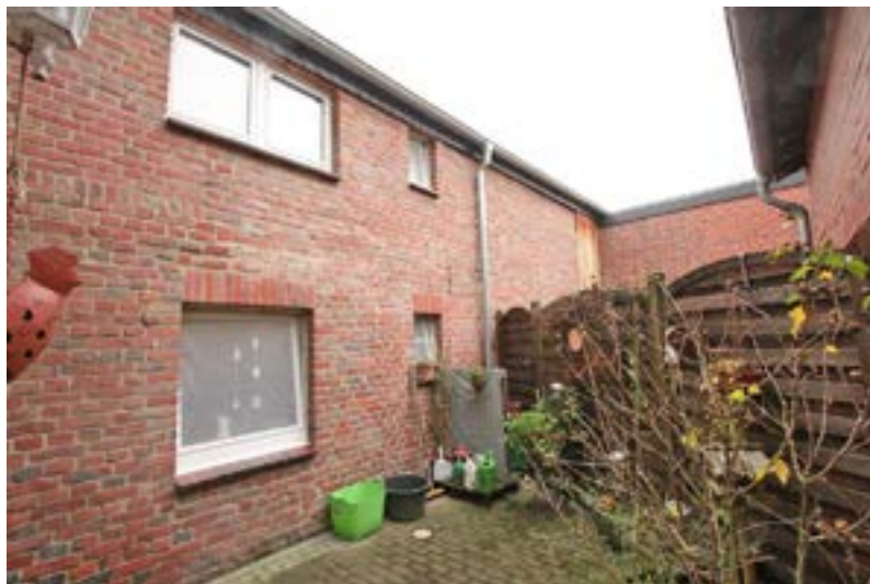
Bild 8: Ansicht des Anbaus an Haus Nr. 149 aus südöstlicher Richtung
