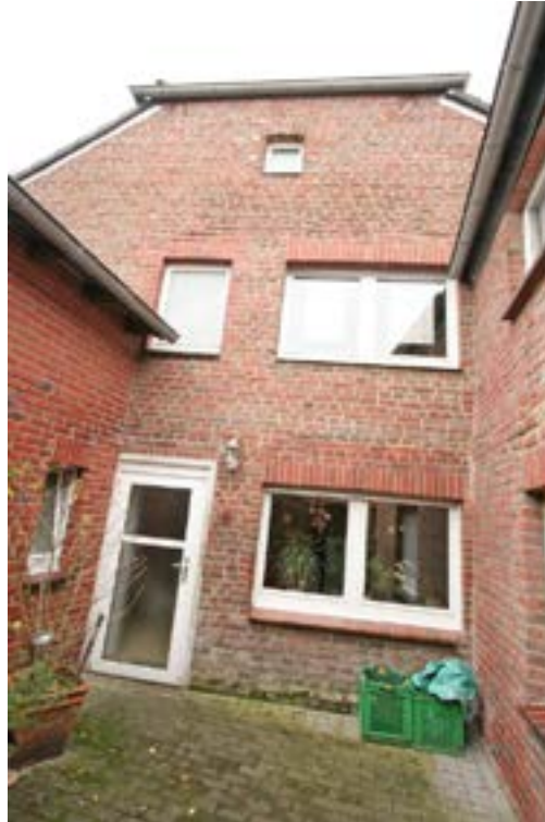
Bild 7: Ansicht der Hoffassade des Hauses Nr. 149 aus nördlicher Richtung
