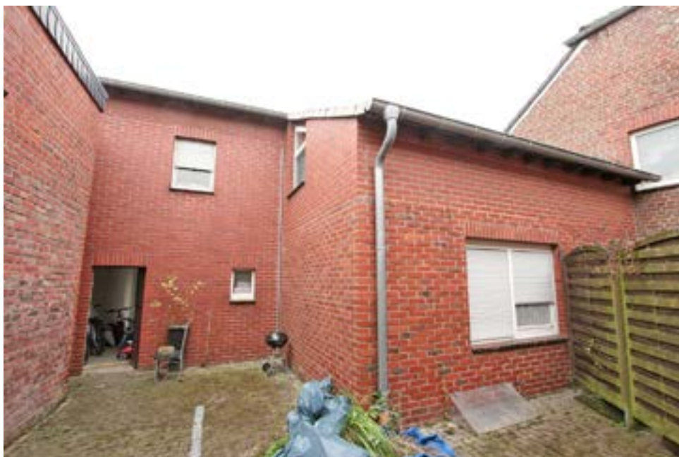
Bild 10: Ansicht des Anbaus an Haus Nr. 151 aus nordwestlicher Richtung
