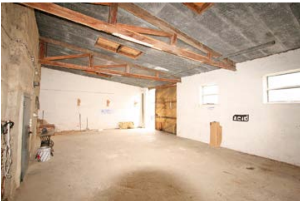
Bild 16: Innenansicht des Hauptraums der Scheune
