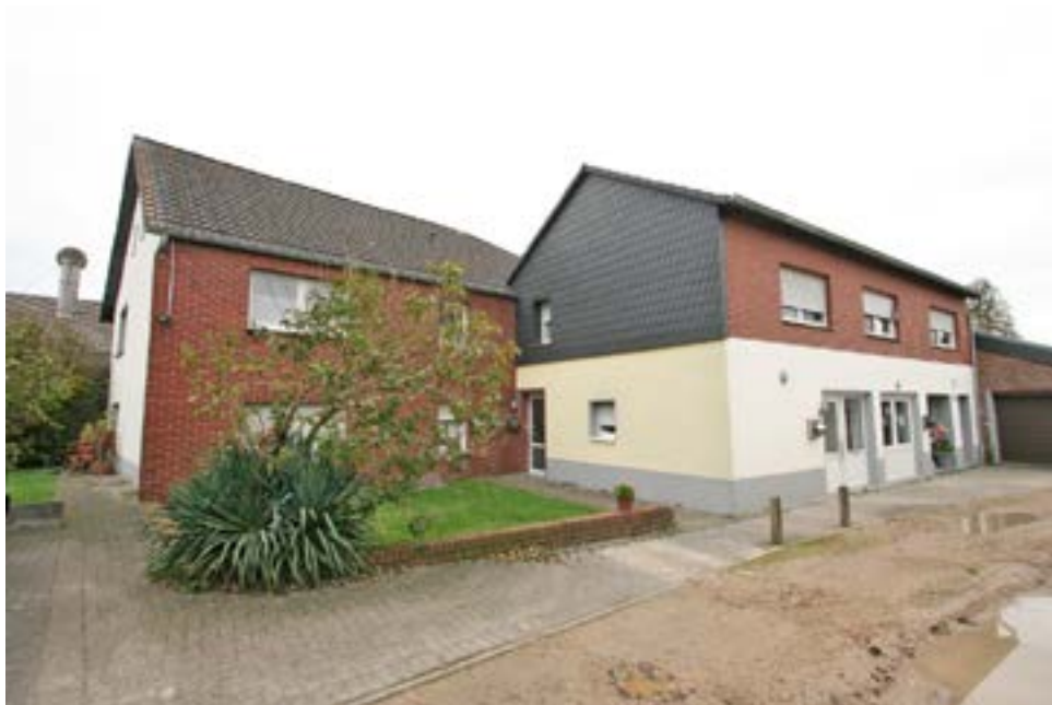
Bild 2: Ansicht der Wohnhäuser und der Garage aus südöstlicher Richtung
