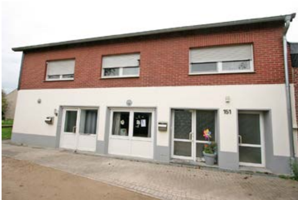
Bild 5: Vorderansicht Haus Nr. 151 aus östlicher Richtung
