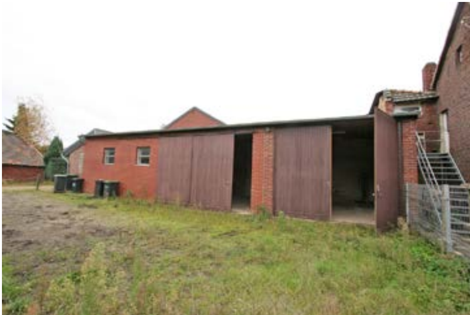
Bild 15: Ansicht der Scheune aus nordwestlicher Richtung
