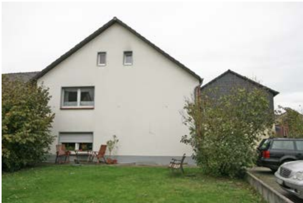
Bild 4: Ansicht der beiden Wohnhäuser aus südlicher Richtung
