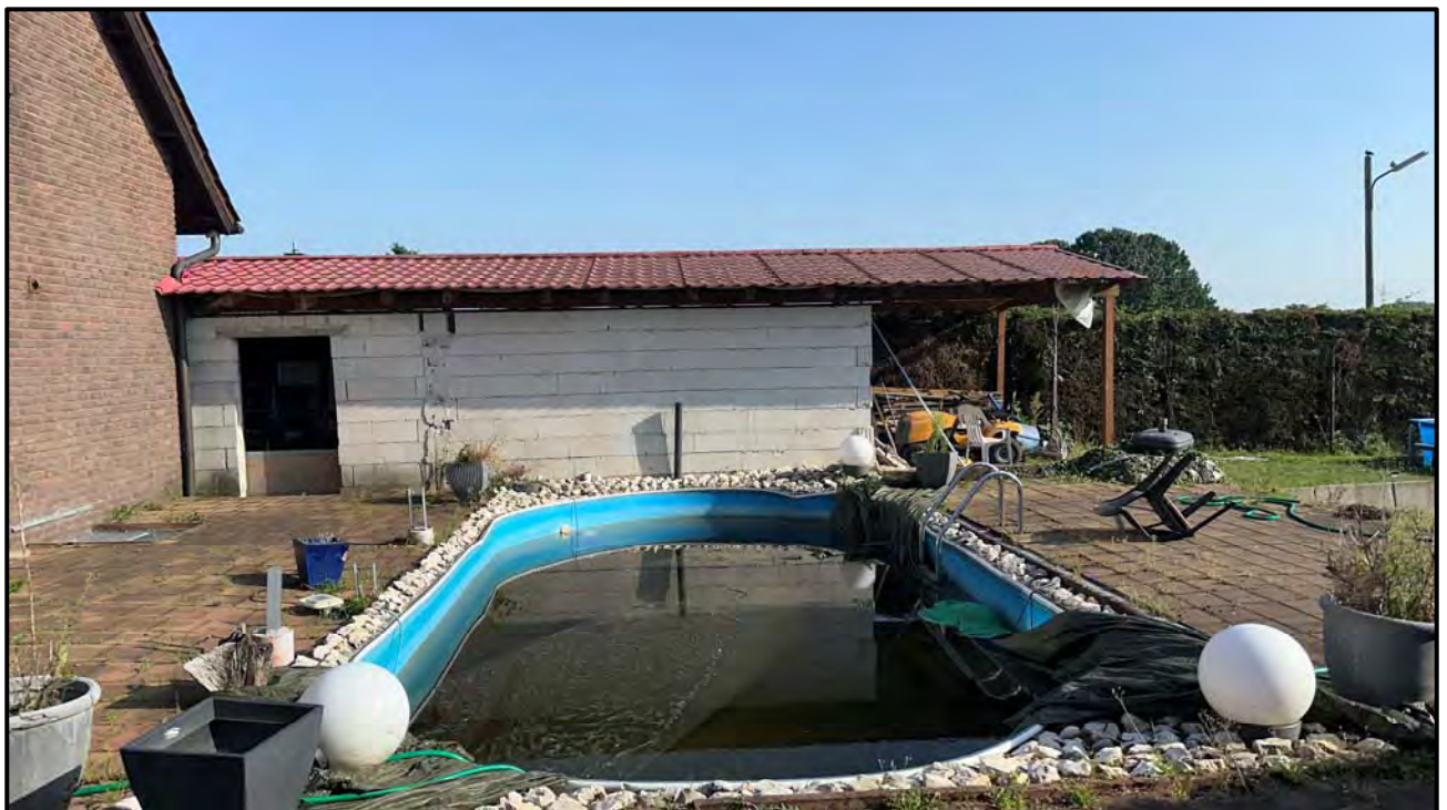
PKW-Garage (eingehauster Carport) (7)
