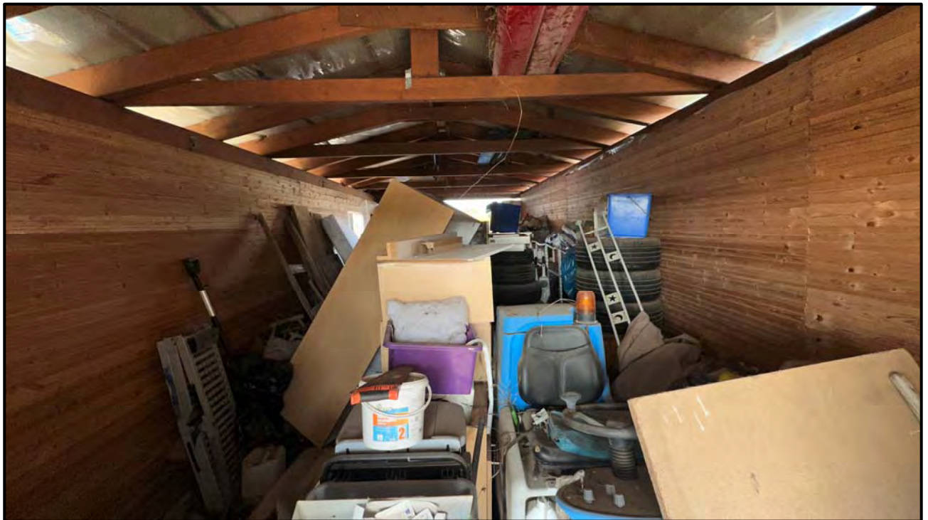
PKW-Garage (eingehauster Carport) (7)
