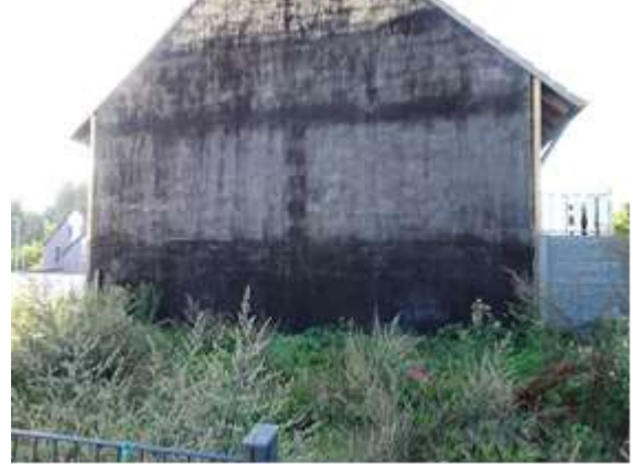
Nachbargebäude an seitlichen Grundstücksgrenze
