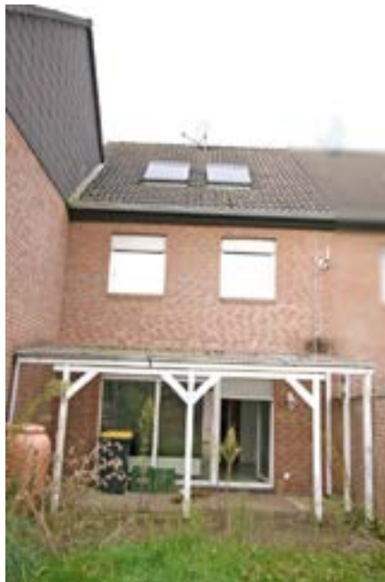
Bild 2: Ansicht des Bewertungsobjekts aus südöstlicher Richtung
