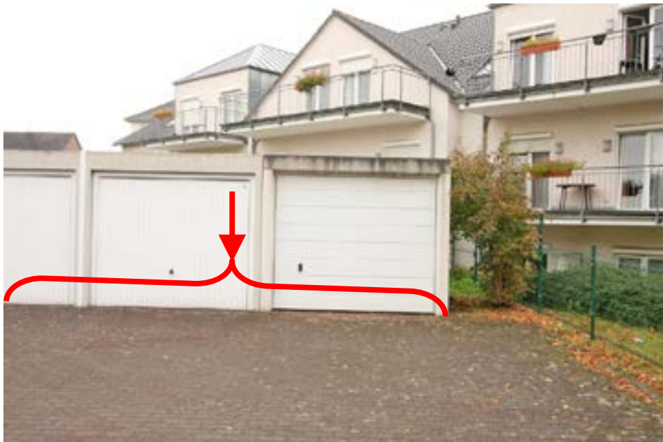
Bild 20: Grundstücksfläche, auf der eine Stellplatzbaulast zugunsten des Bewertungsobjekts eingetragen ist, die jedoch nicht dinglich gesichert ist
