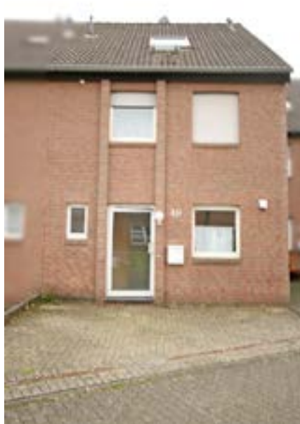
Bild 1: Straßenansicht des Bewertungsobjekts aus nordwestlicher Richtung
