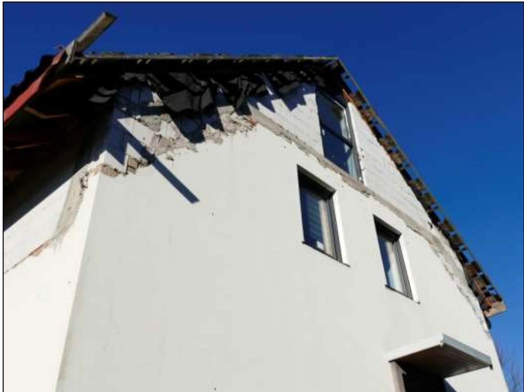
Ortgang + Dachentwässerung unfertig
