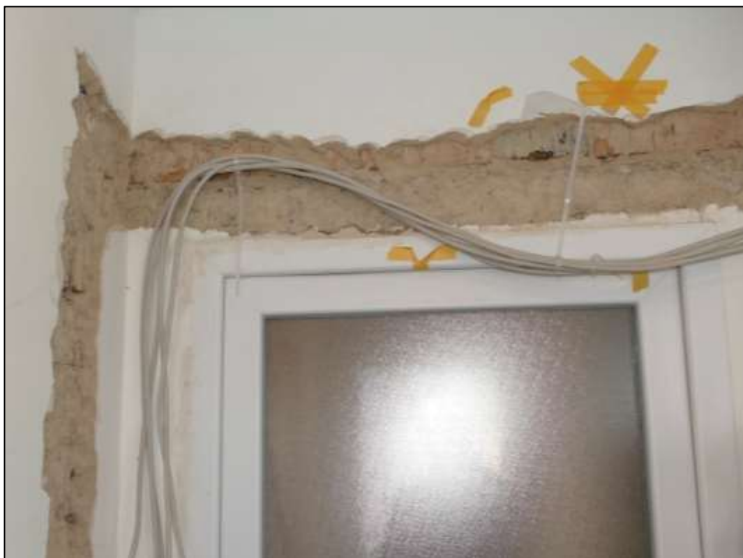
beginnene Umlegung der Stromleitungen
