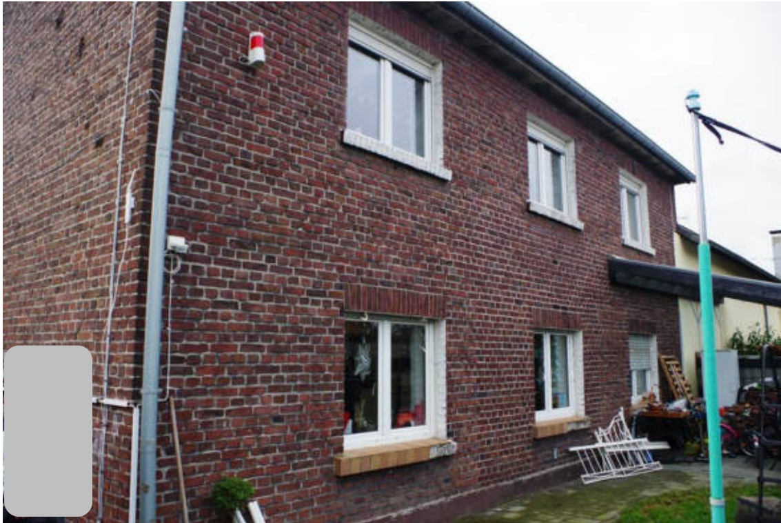
Bild 1: Hofansicht des Einfamilienhauses aus Ost
