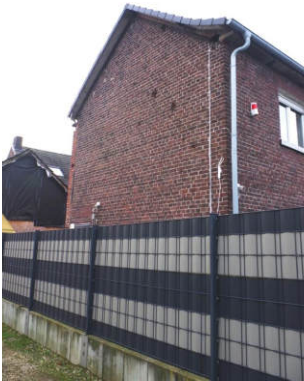
Bild 3: Giebelansicht des Einfamilienhauses aus Südost
