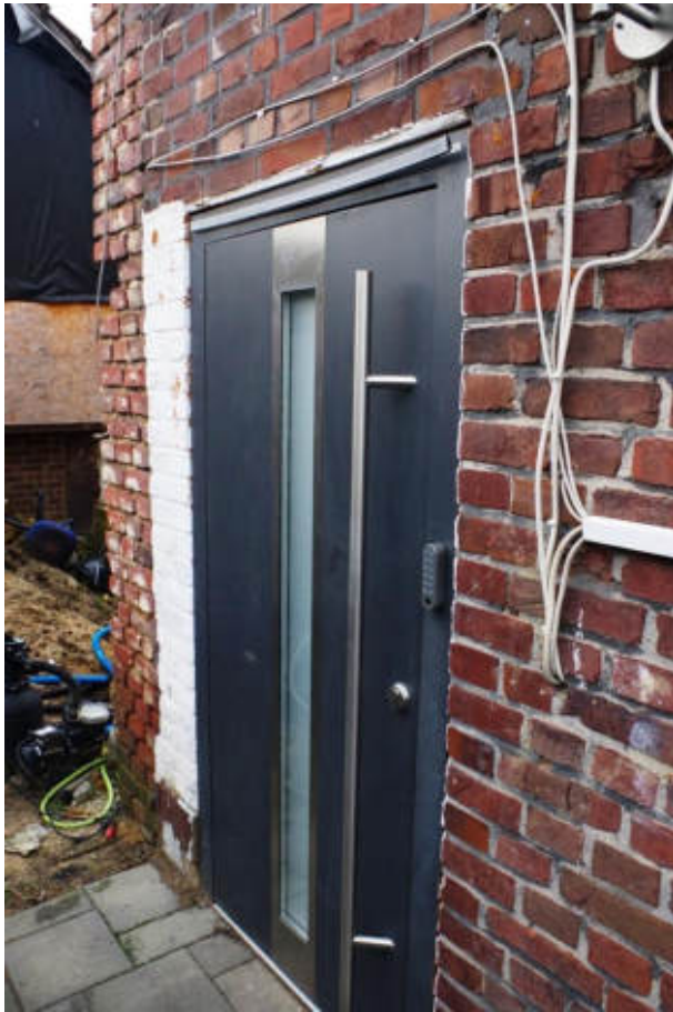
Bild 9: Detailansicht des Hauseingangs
