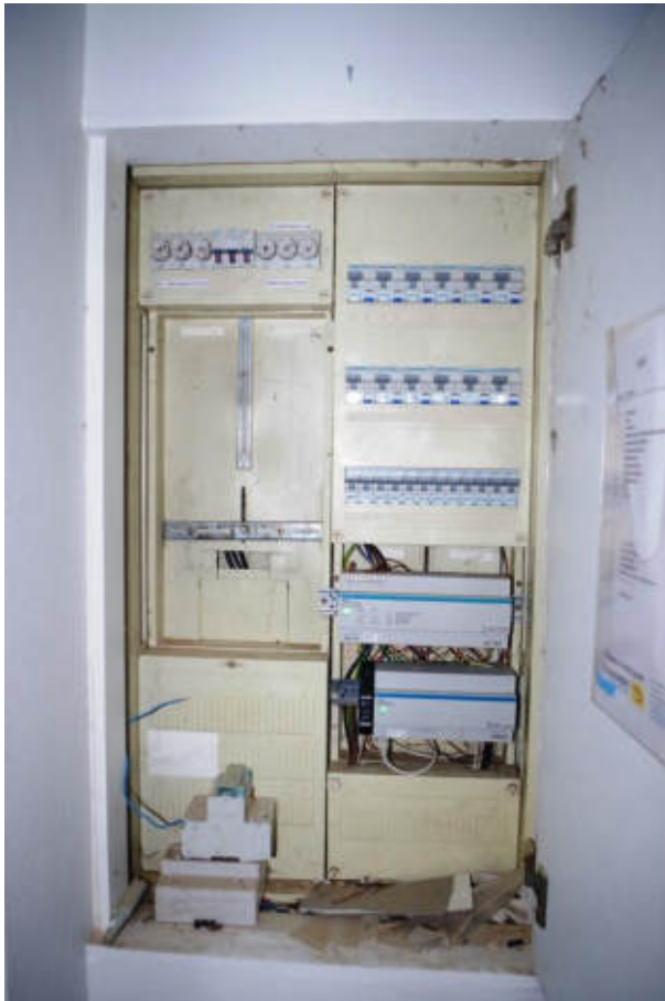
Bild 29 und Bild 30: Stromzähler / Stromverteilung
