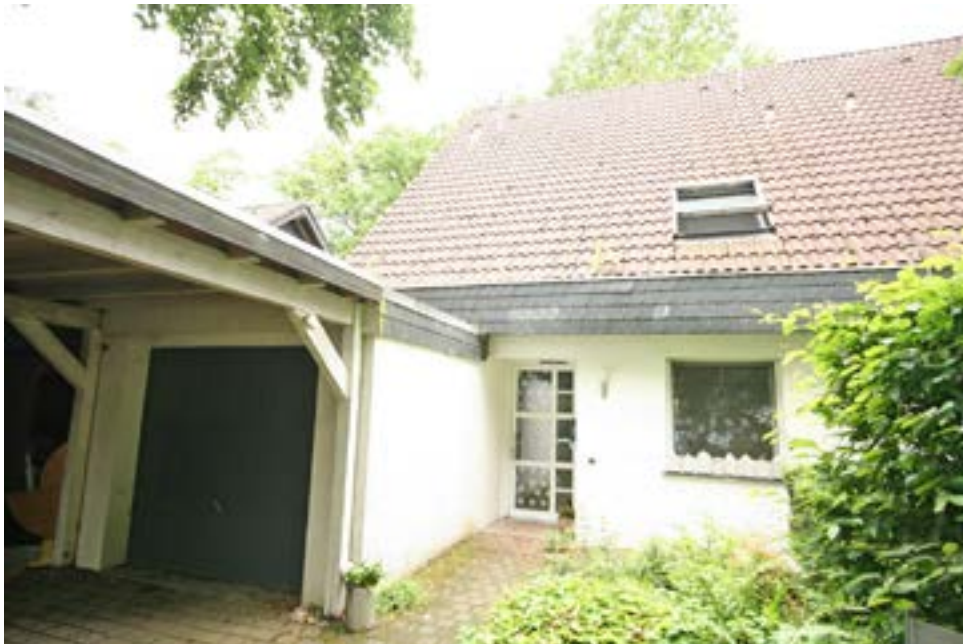
Bild 3: Vorderansicht des Bewertungsobjekts aus östlicher Richtung
