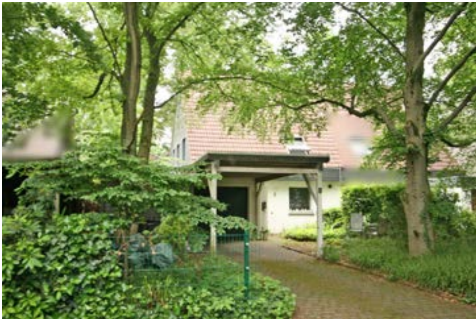
Bild 1: Straßenansicht des Bewertungsobjekts aus südöstlicher Richtung
