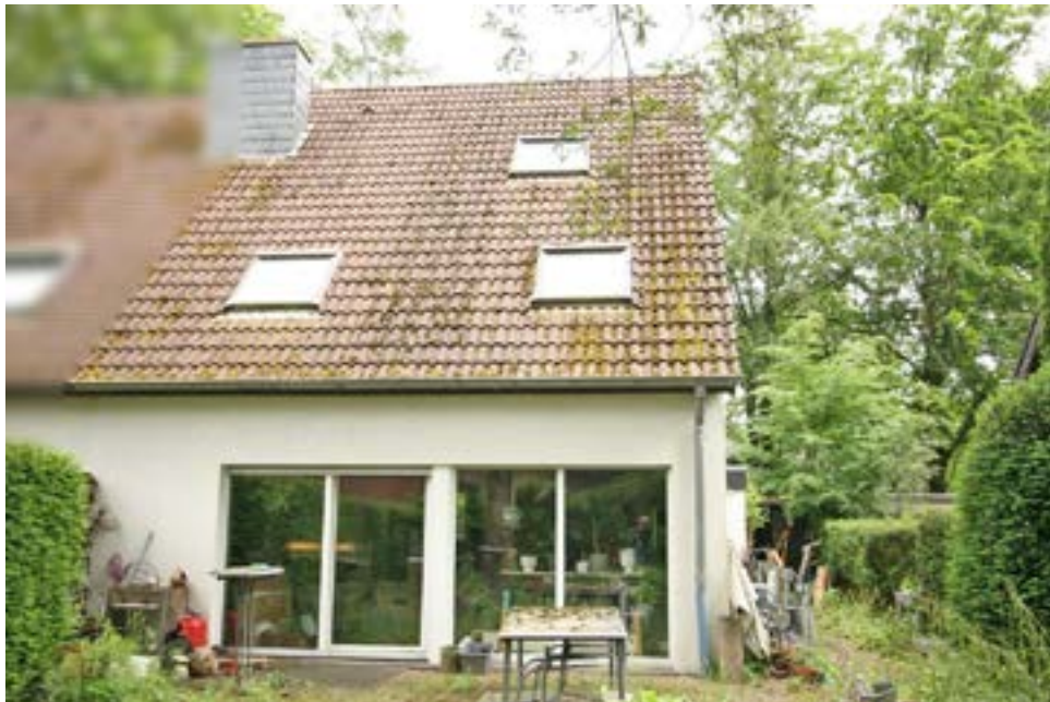
Bild 5: Rückansicht des Bewertungsobjekts aus nordwestlicher Richtung
