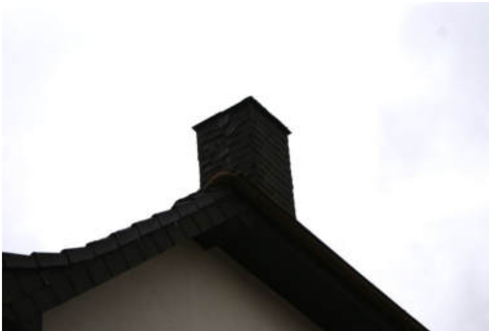
Bild 53 Schadhafter Schornsteinkopf Nordseite
