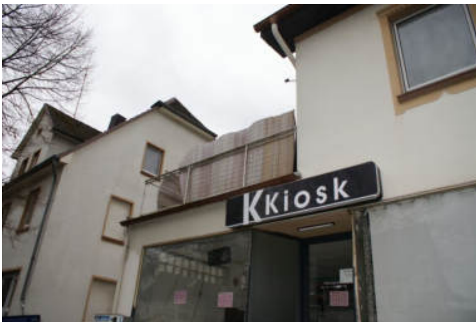
Bild 17 Anbau mit Kiosk im EG, darüber Terrasse OG an der Grenze
