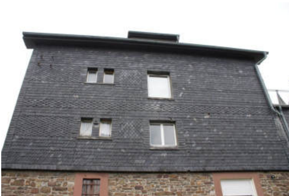
Bild 12 Rückseite EG und OG über Bruchsteinmauerwerk UG
