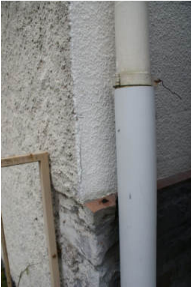
Bild 51 Putzschaden an der Nordostecke
