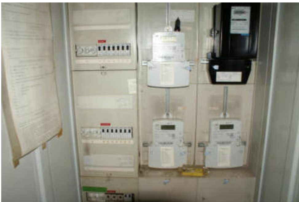
Bild 39 Teilmodernisierter Zählerschrank
