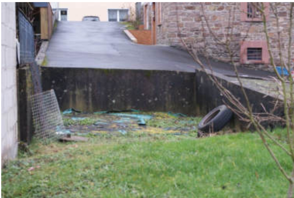
Bild 31 Blick vom Garten auf Rampe zur Straße und Stützmauern
