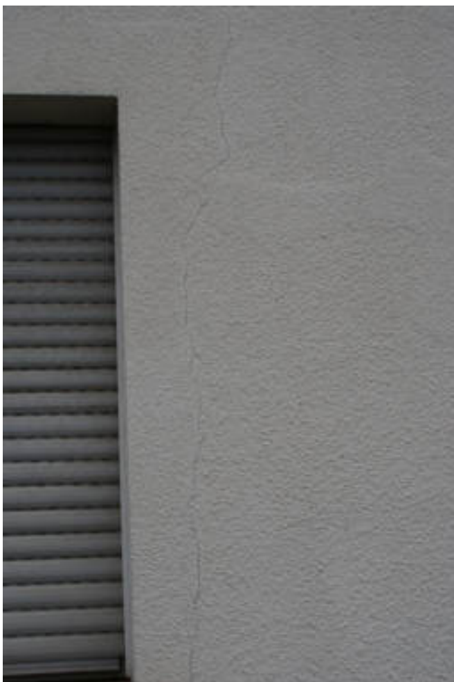
Bild 45 Detail Riss neben dem Fenster EG
