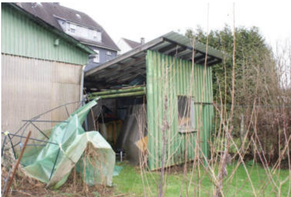
Bild 28 Detailansicht halboffener Schuppen
