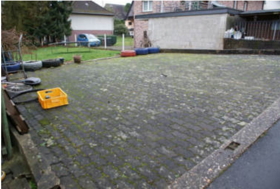
Bild 25 Befestigte Stellplätze nördlich des Carports
