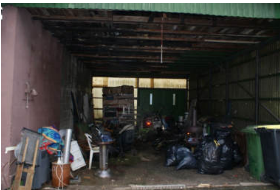
Bild 24 Blick in den Carport
