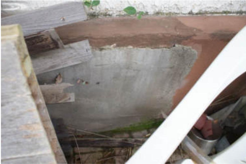
Bild 61 Putzschäden Sockel Rückseite zur Terrasse
