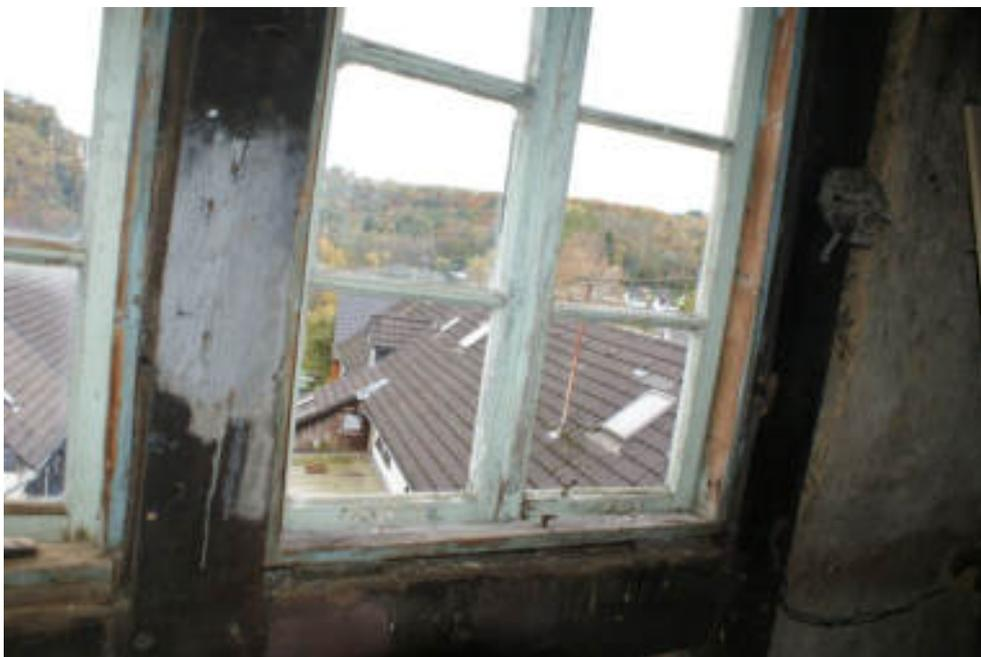
Bild 88 Desolate Fenster DG / fehlende Scheiben
