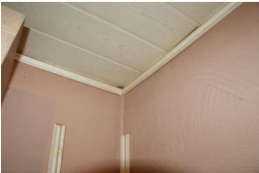
Bild 83 Mangelhafte Deckenpaneele / Fehlstelle / Verfärbungen durch Russ vom Ofen im Wohnraum
