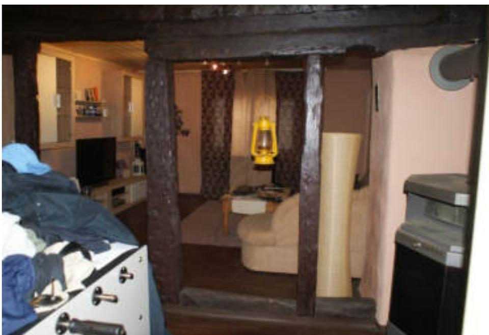
Bild 28 Wohnraum von hinten nach vorne / Offenes Fachwerk als Raumteiler mit Bodenschwelle
