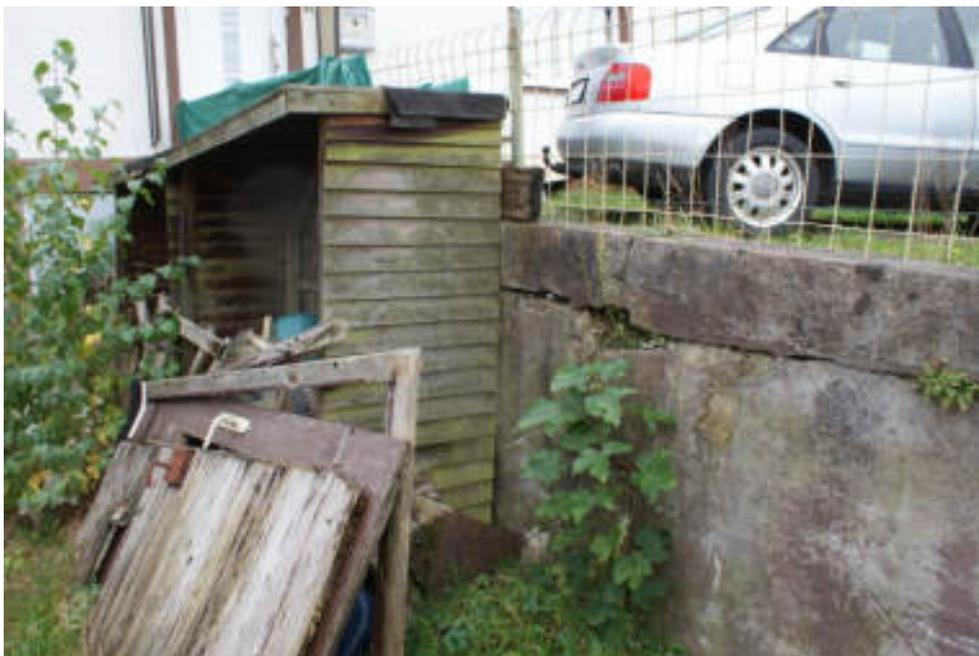
Bild 53 Alter desolater Holzverschlag am Zugang zum Keller / Risse in der dahinter liegenden Stützwand zum Hauseingang
