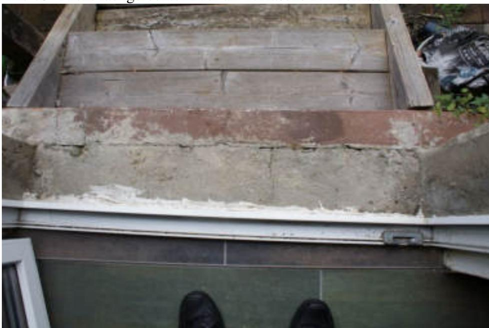
Bild 74 Schäden am Ausgang zur Terrasse, Mauerwerk und Sockel
