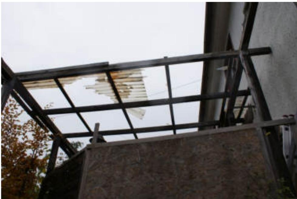
Bild 93 Desolate Terrassenüberdachung / lt. Angabe Sturmschaden
