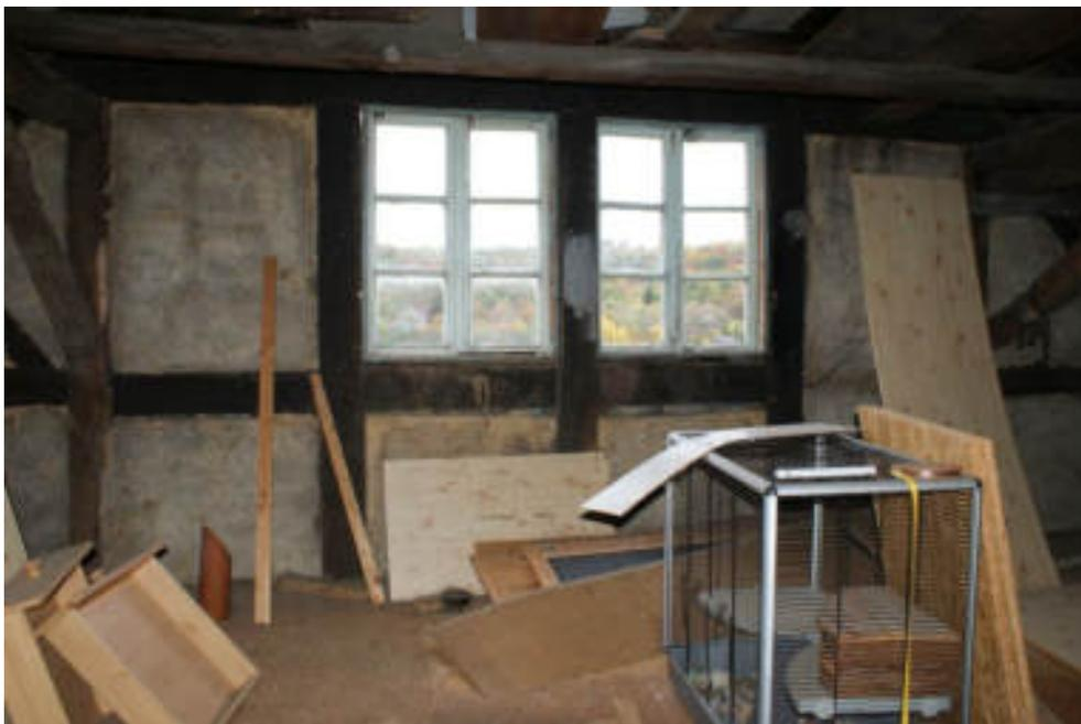
Bild 46 Dachboden, Giebelseite Ost mit Fachwerk und desolaten alten Fenstern
