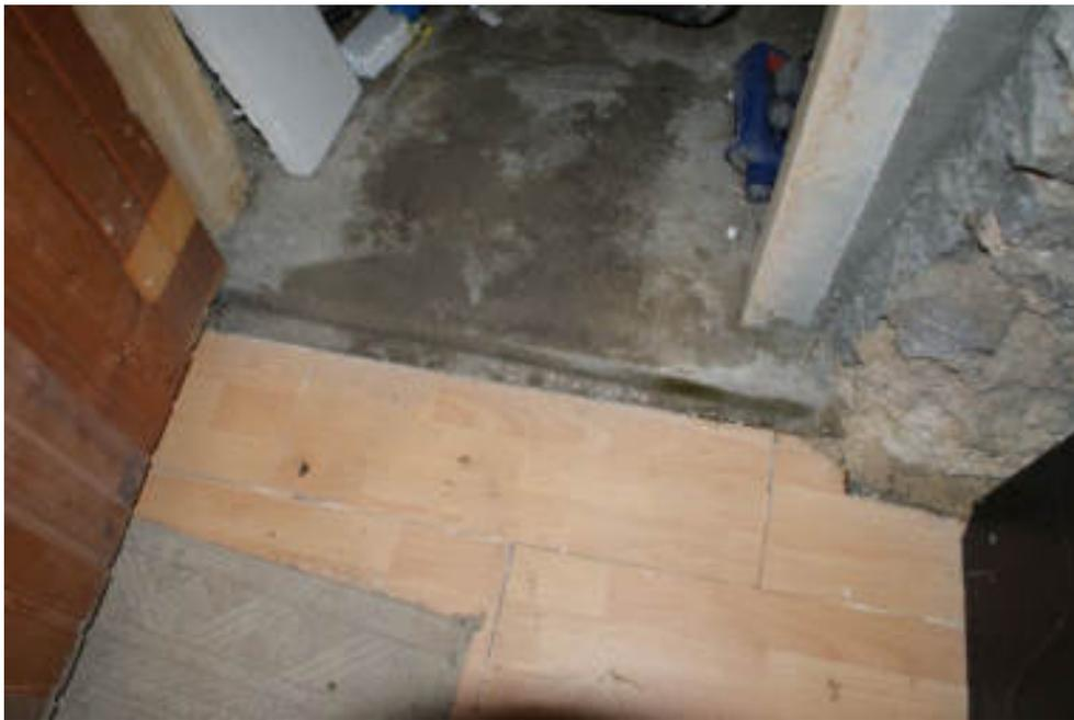
Bild 71 Nicht geeigneter Laminatboden im KG / Übergang auf Betonboden
