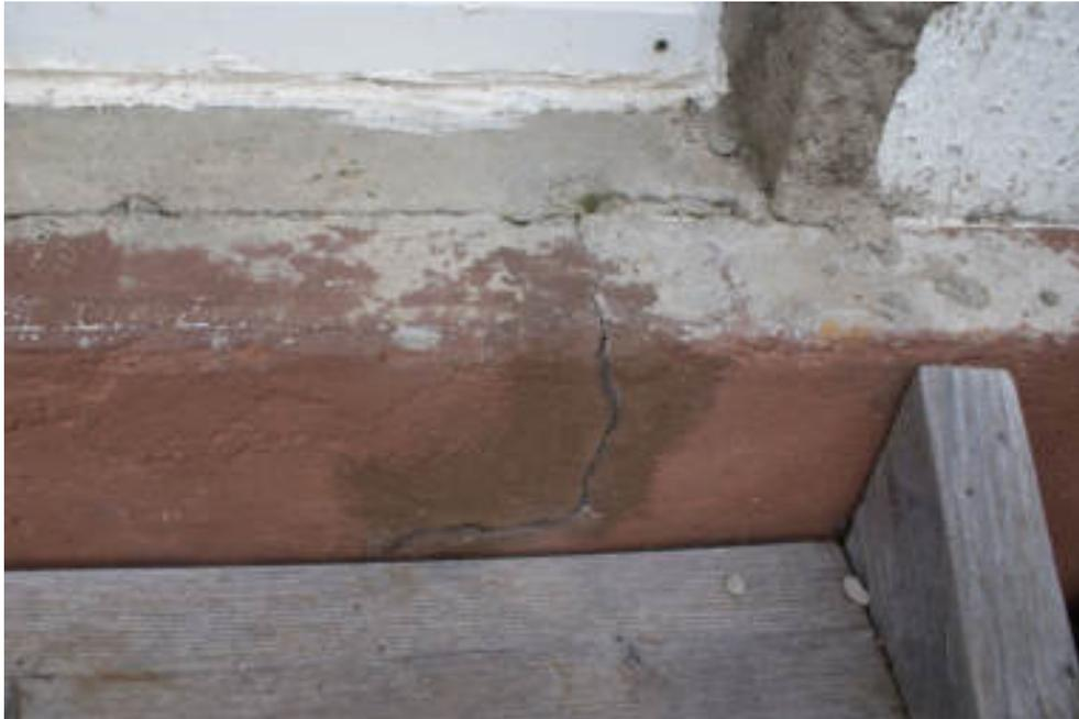
Bild 77 Tiefer Riss im Sockel am Ausgang aus der Küche
