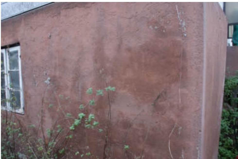
Bild 54 Putzschäden und Durchfeuchtung an der Nordecke Ostgiebel
