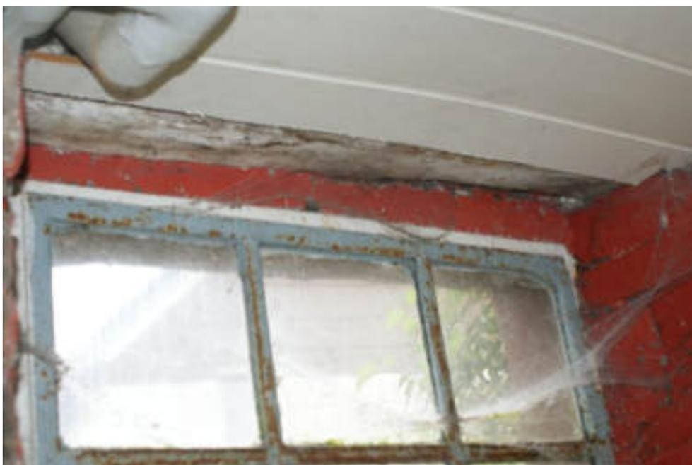
Bild 72 Detail Rostbefall am Stahlfenster
