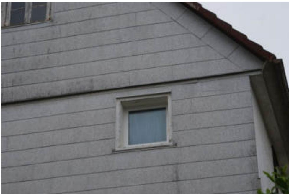
Bild 63 Ostgiebel mit alten Fassadenplatten, welche asbesthaltig sein könnten /
