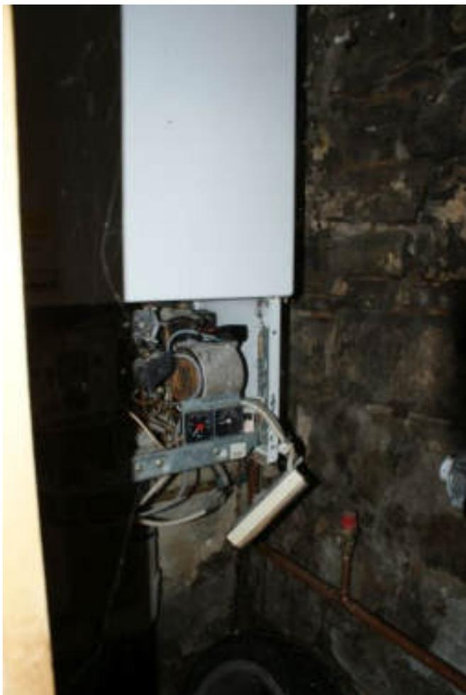
Bild 69 Defekte alte Gastherme
