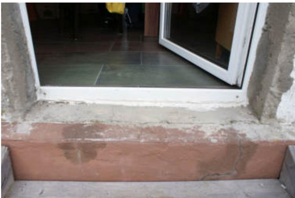
Bild 60 Schäden am Ausgang aus der Küche, besonders am Sockel
