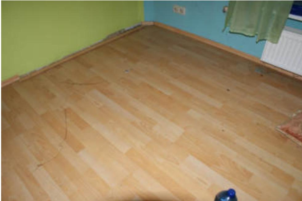
Bild 87 Laminatschäden im Kinderzimmer OG, schadhafte Fußleiste
