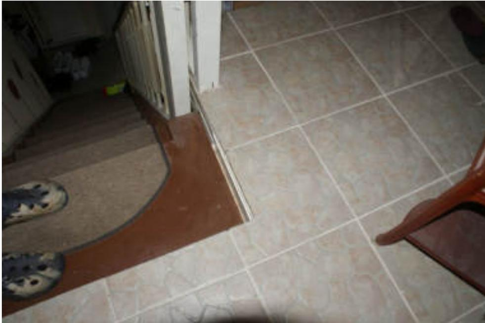
Bild 85 Niveauunterschied Diele zum Kellerabgang
