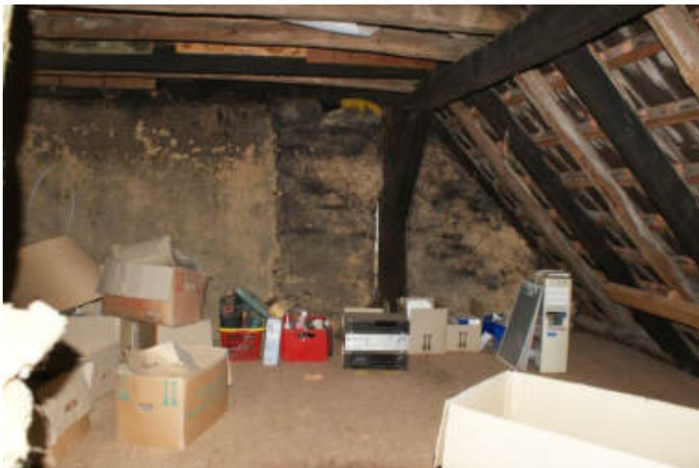
Bild 47 Dachboden gegenüberliegende Seite / nicht gedämmtes Dach
