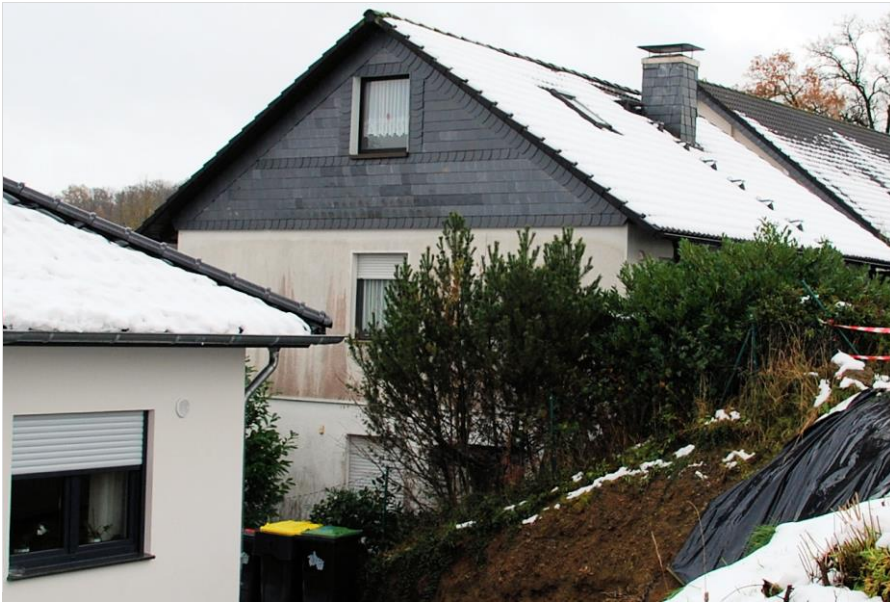
Foto 4 An der Furth 32, Nordseite
