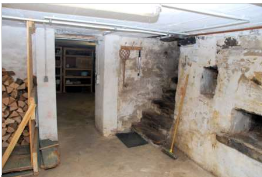
Foto 29 Geiningen 31, Kellergeschoss, Treppe
