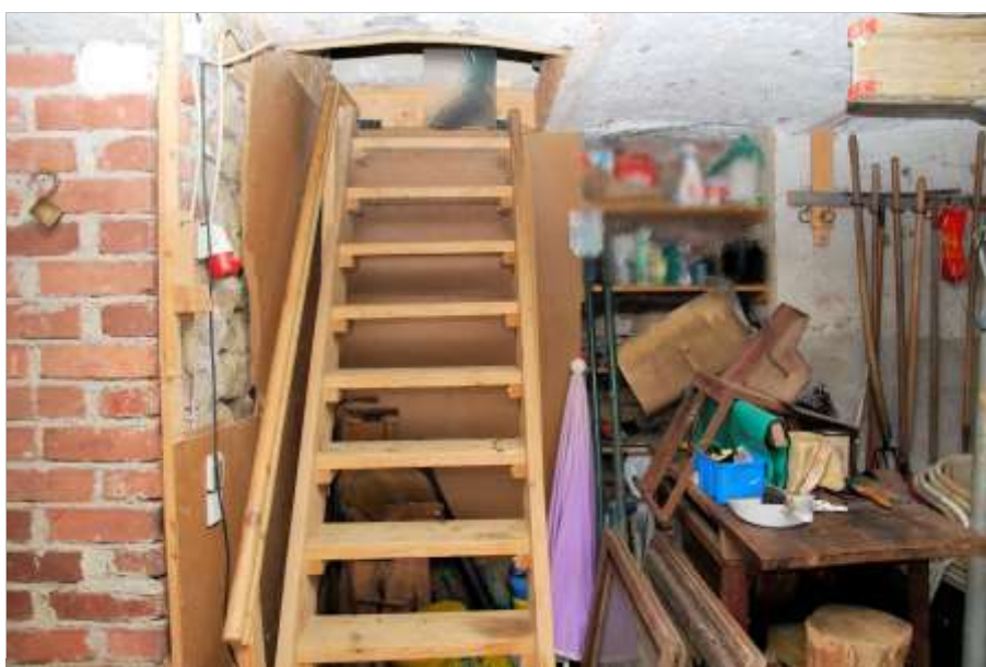
Foto 33 Geiningen 31, Garage mit Treppe zum Obergeschoss
