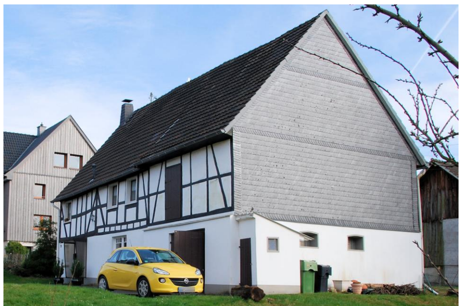
Rückseitiger Giebel (Westen) und Nordseite
