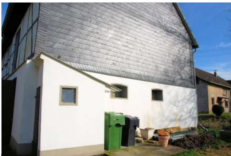
Foto 5 Geiningen 31, Westseite mit ehemaliger Toilette
