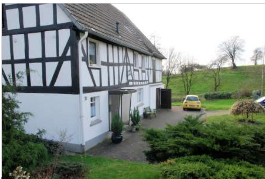
Foto 3 Geiningen 31, Straßenseite (Osten) und Nordseite mit Hauseingang
