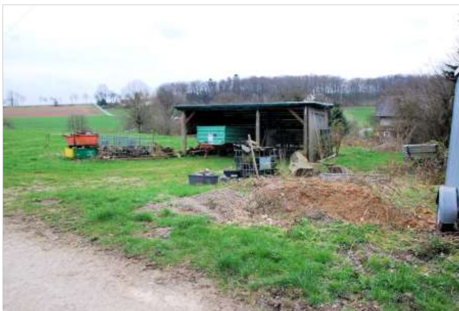
Foto 40 Gemarkung Hermesdorf Flur 51 Flurstück 34, Nordwestteil mit Unterstand
